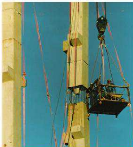
Figura 3.3 – Ligação pilar-pilar
