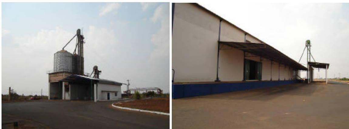
Figura 4.11 - Instalações da área de transbordo e depósito da CASEMG
