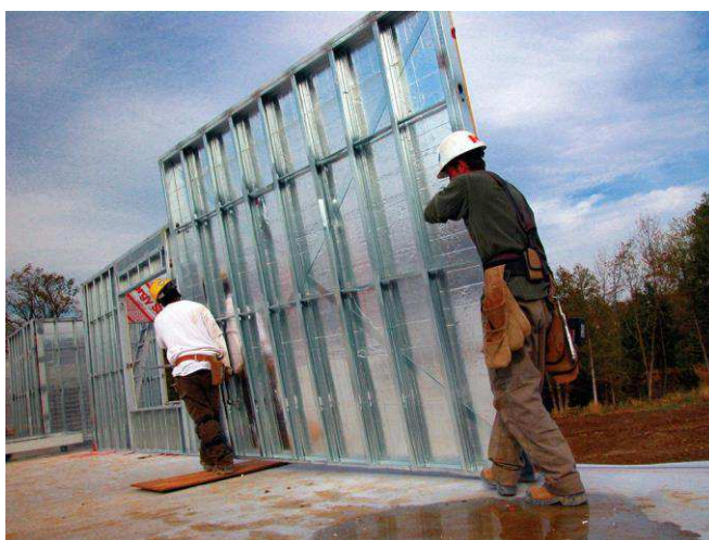
Figura 5 - Pré-fabricação de painéis e montagem no local (método por painéis)
