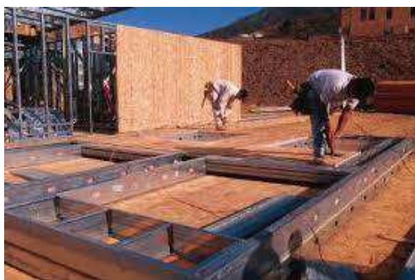
Figura 4 - Construção pelo método stick
