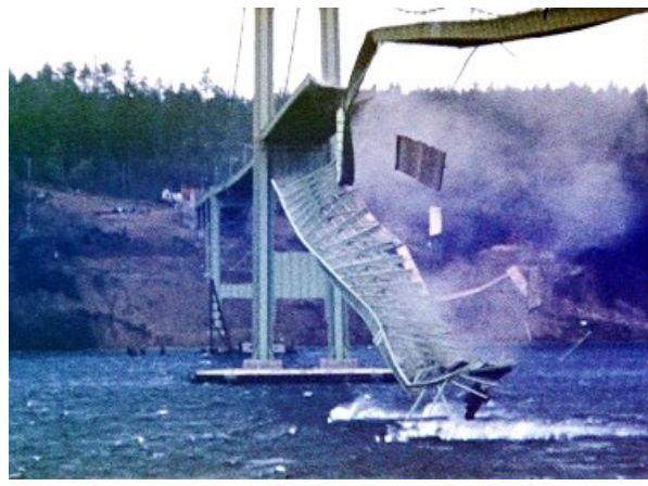
(b) Tacoma após entrar em colapso.
