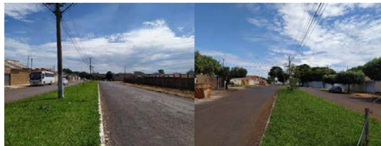
Figura 95: ruas coletoras – avenida Iguaçu e avenida Santa Catarina.
