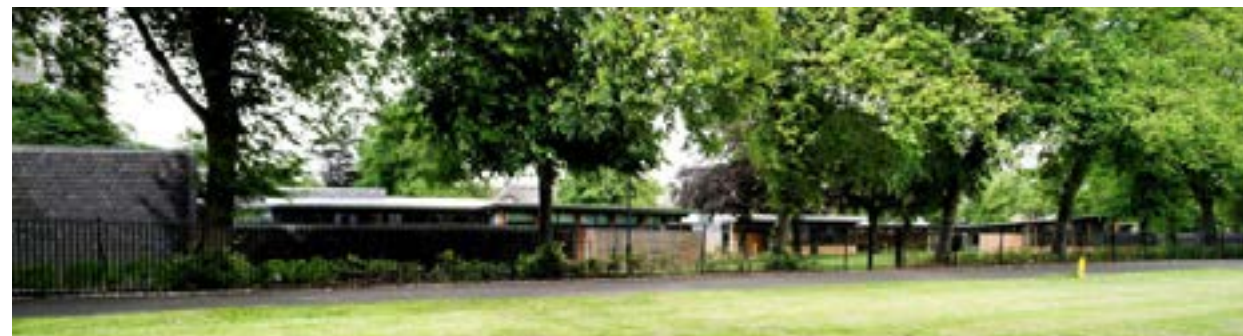
Figura 63: vista externa da escola, demonstrando a escala pequena da edificação.
