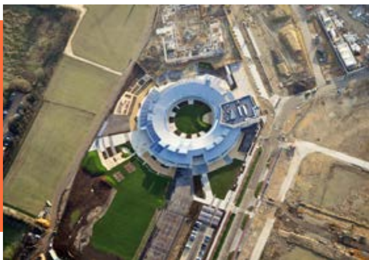
Figura 81: placas fotovoltaicas na cobertura.
