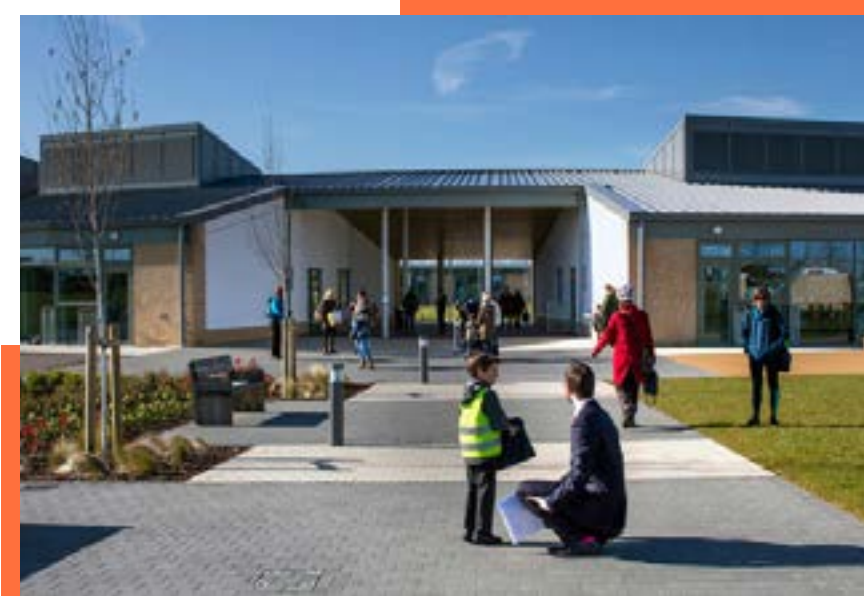
Figura 78: circulação externa- espaço de encontros informais.
