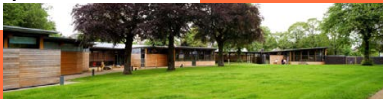
Figura 65: área externa norte.
