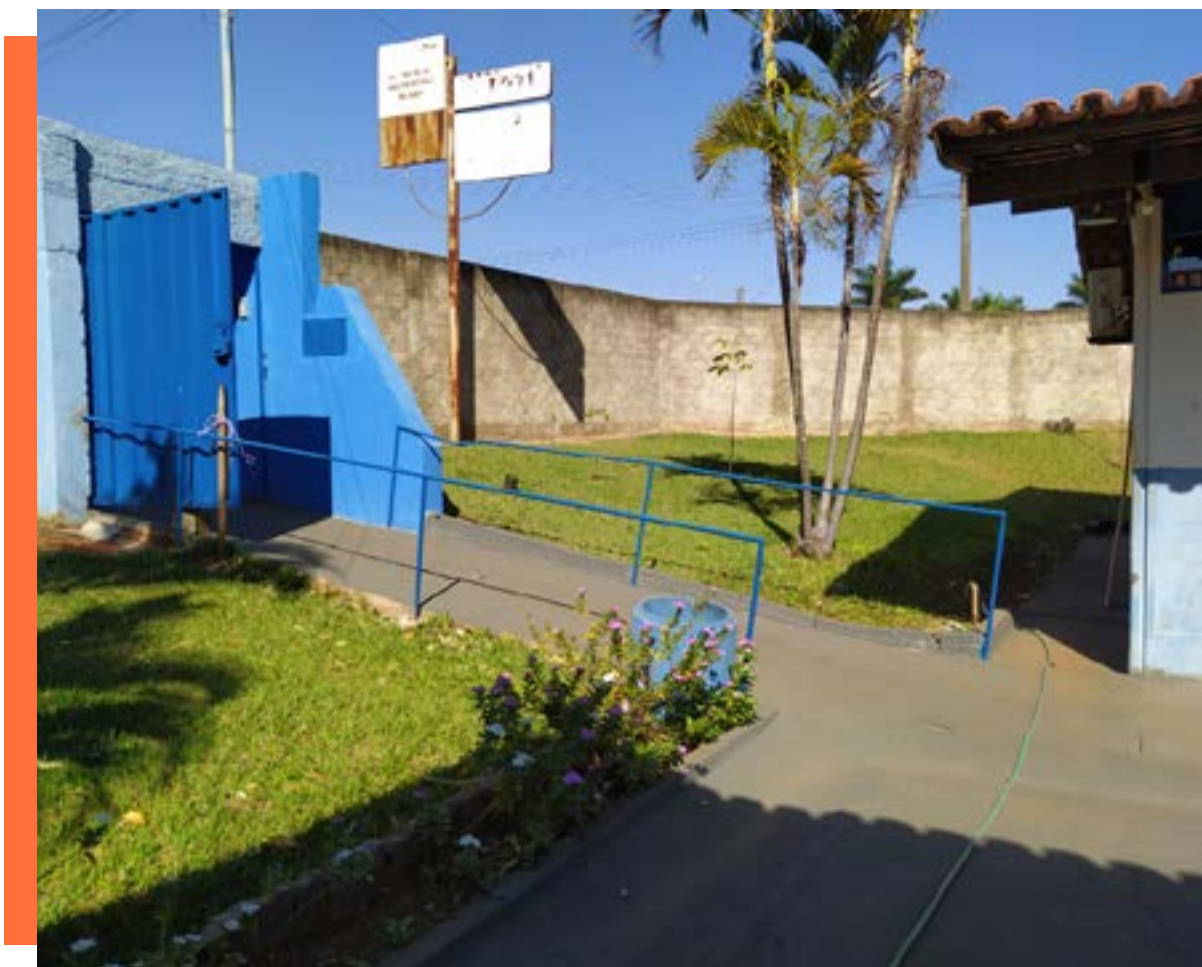
Figura 43: rampa de acesso.
