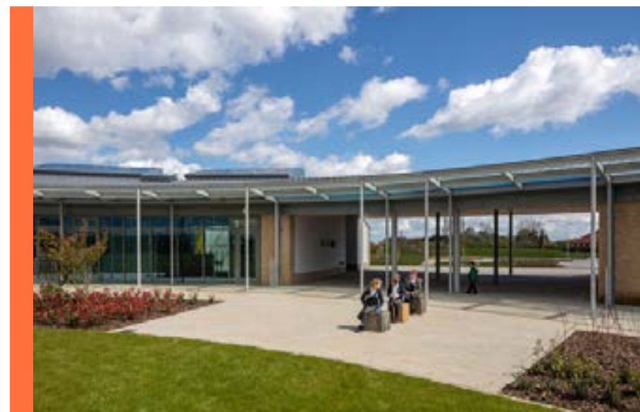
Figura 80: uso de vidros e tijolos para as vedações.
