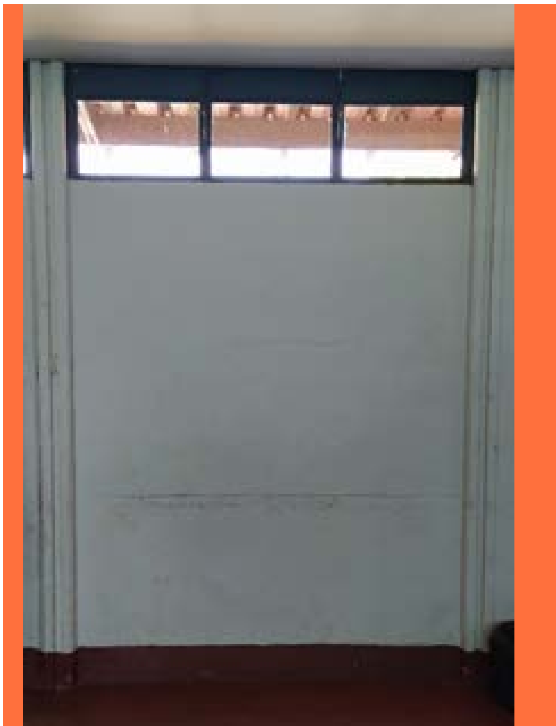
Figura 41: parede em placa cimentícia.
