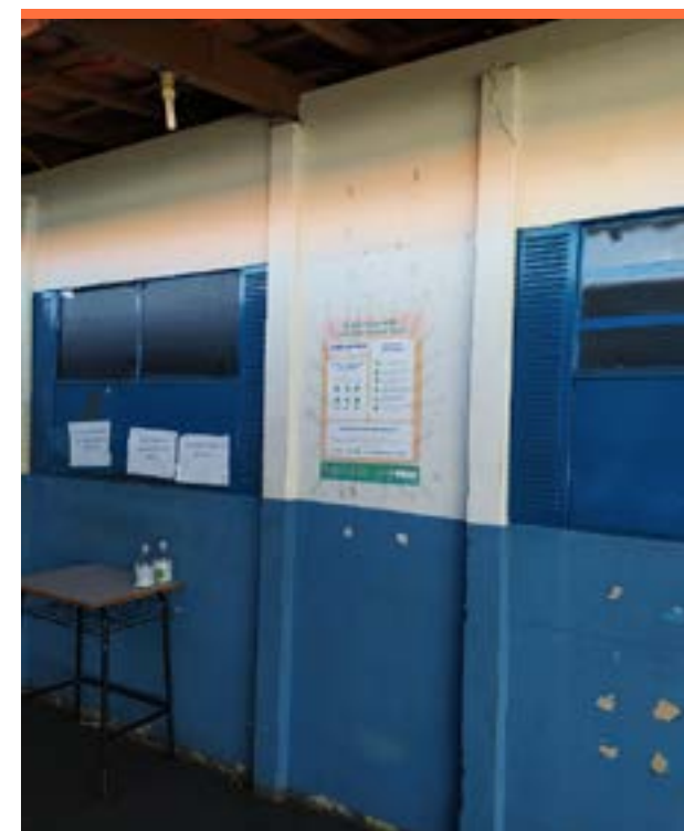
Figura 18: Paredes da EEESFA, feitas com placas cimentícias.
