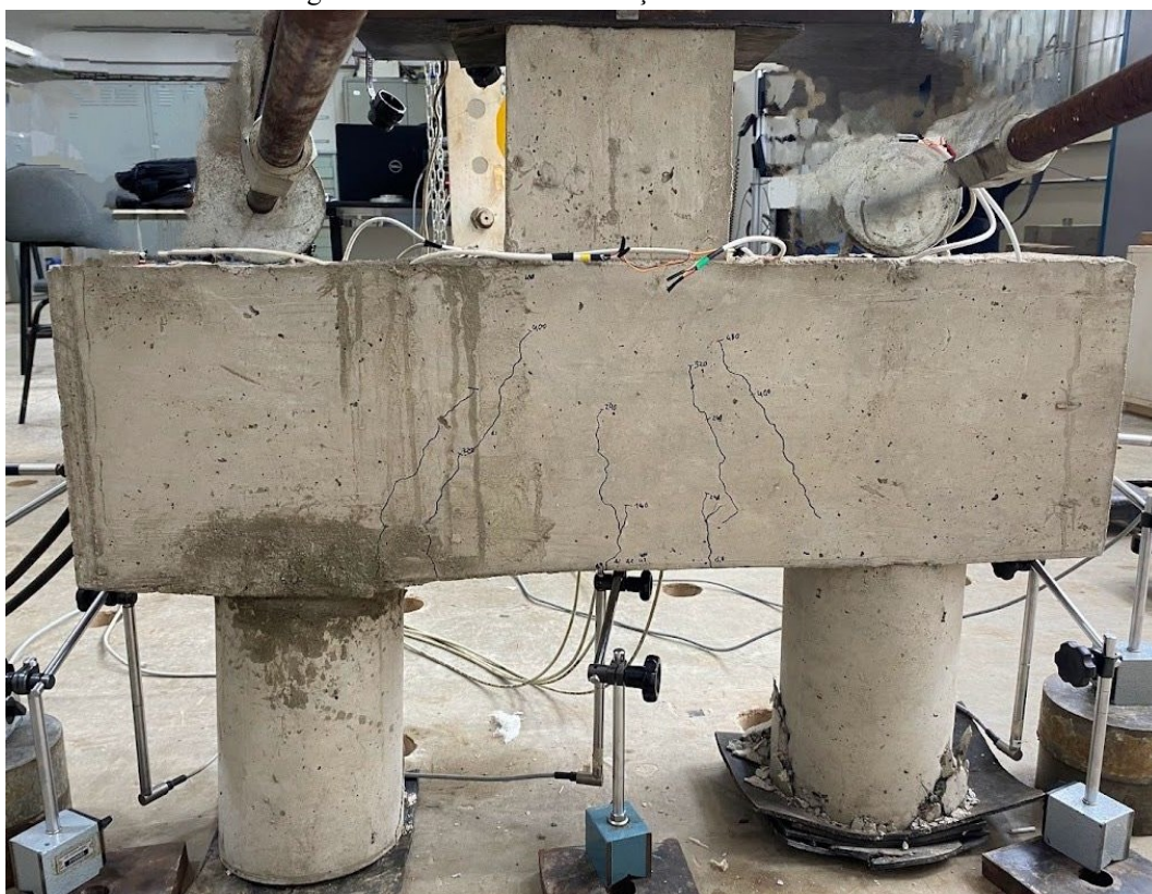
Figura C.7 – Padrão de fissuração bloco BF20A201
