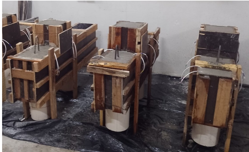
Figura 41 – Concretagem dos blocos
