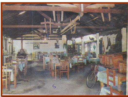
FOTO 17: Foto do interior do Restaurante Caipira
