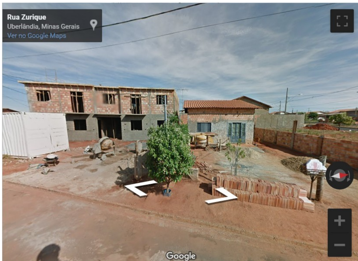
Figura 2 - Foto da rua Zuriq, no Bairro Jardim Europa, Uberlândia-MG, 2021
