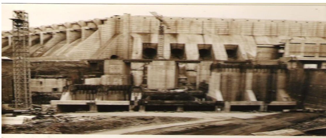
Figura 9: Construção da barragem de concreto ainda com estruturas de ferro como apoio.
