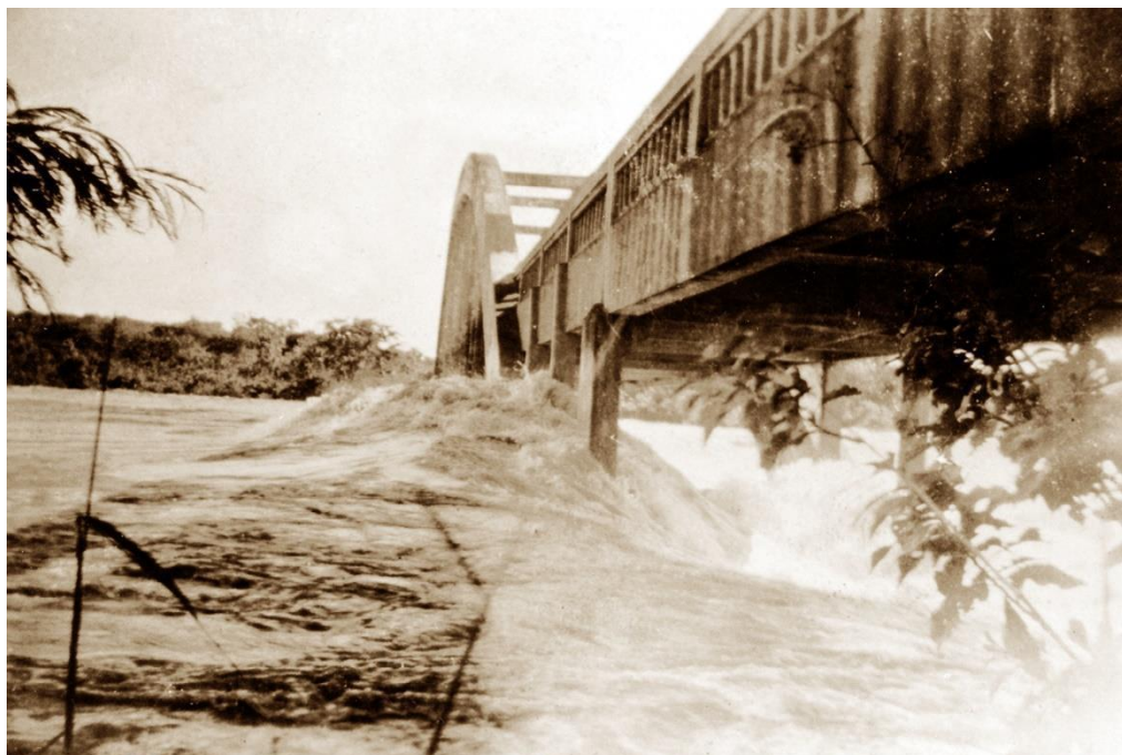
Figura 2: Enchente derruba a ponte
