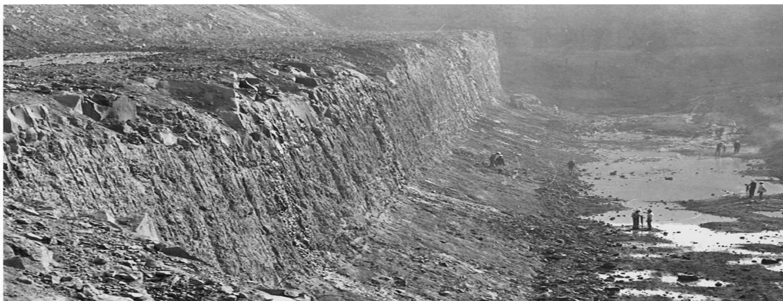
Figura 8: Homens trabalhando no canal desvio da futura barragem
