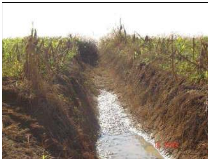
Figura 10 – Vala de drenagem construída em campo hidromórfico
