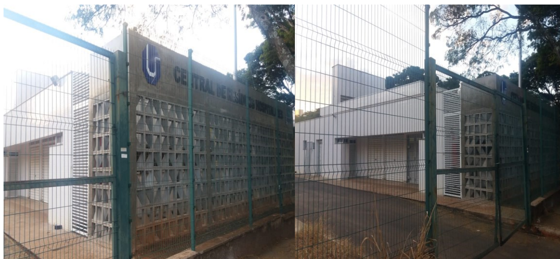
Figura 12 - Abrigo de armazenamento externo e Central de Resíduos Hospitalares.
