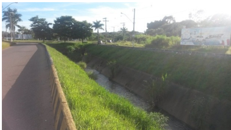
Figura 5: Canal aberto Córrego Rangel
