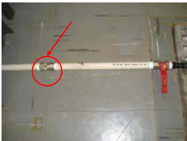
Figura 6.2 - Válvulas de saída do sistema de neutralização para estimação de parâmetros.
