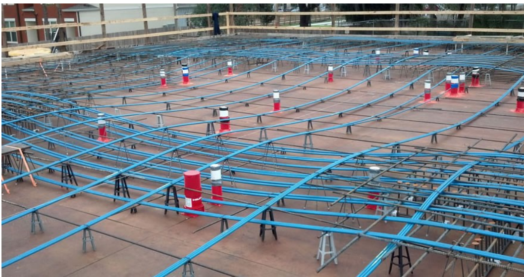
Figura 12 – Montagem das armaduras de uma laje lisa protendida
