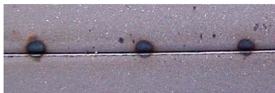
Falta de fusão
