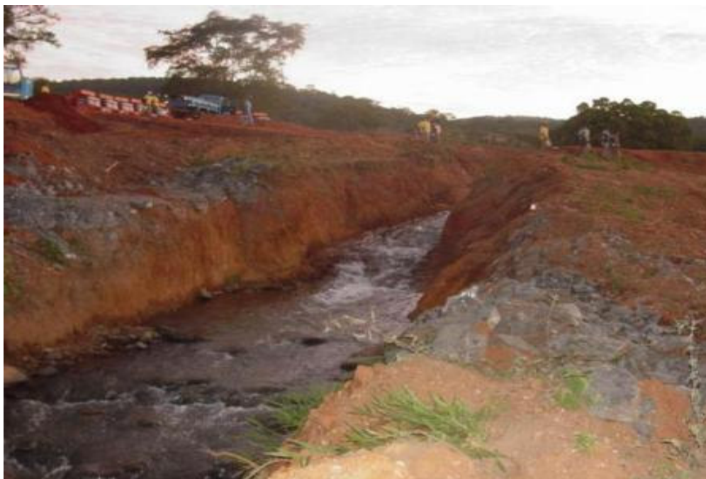
Foto 42: Desvio do Córrego dos Macacos, afluente da margem esquerda do rio Araguari. Autora: Ferrete, J. A., maio de 2005.
