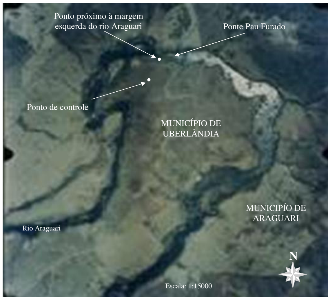
Figura 8: Foto aérea com a localização dos pontos onde se instalava a armadilha de Shannon na área de construção da barragem da UHE Capim Branco I.
