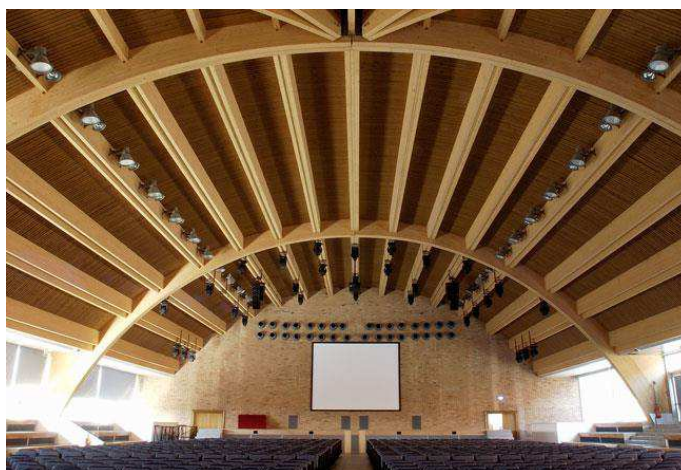
Figura 3 – Cobertura em arco de madeira laminada colada
