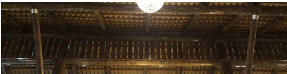
Figura 25 – Viga detalhe entre pórticos
