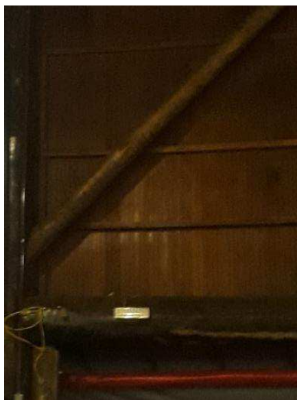
Figura 26 – Ligação entre pilares centrais e peça 'mão francesa'
