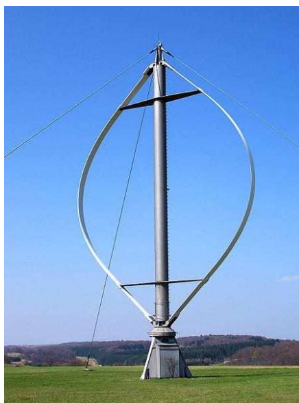
Figura 2 – Aerogerador de eixo vertical do tipo Darrieus
