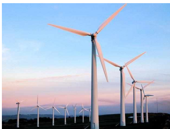
Figura 6 - Aerogerador de eixo horizontal
