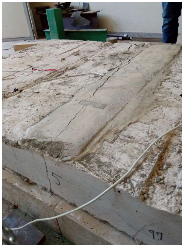
Figura 19 — Laje 3ST - Ruptura
