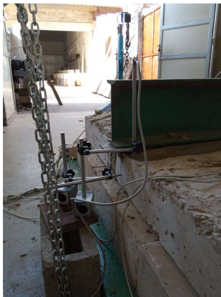
Figura 15 — Posicionamento lateral dos transdutores
