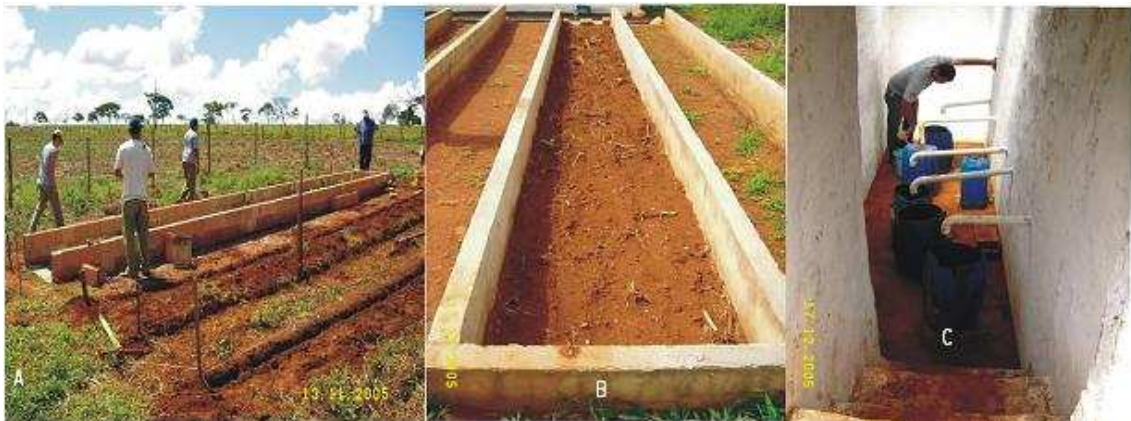
Fig.09) a- Construção da nova estrutura. b – Vista da nova parcela. c- Compartimento para recepção de sedimentos e água.
