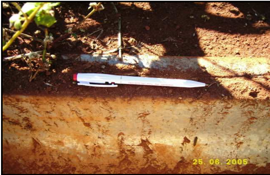
Fig. 14) Sedimento depositado na borda e na parede interna da calha. Autor: Silva,J.B
