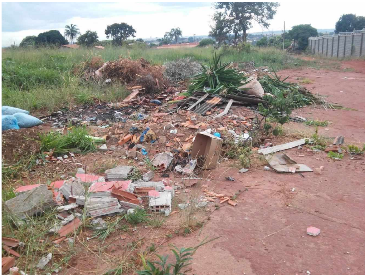
Figura10: Pequeno depósito irregular de resíduos sólidos da construção civil no bairro Independência.
