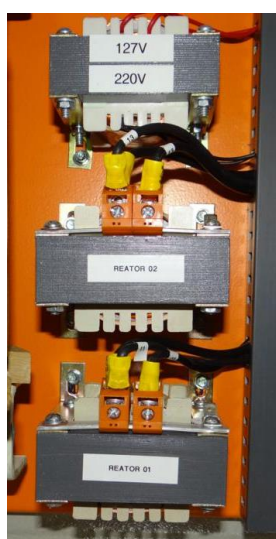
Figura 4.6 - Reator de comutação e transformado para alimentação do controle e das chaves
