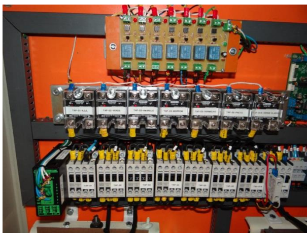
Figura 4.4 - Dispositivo de seleção de tape
