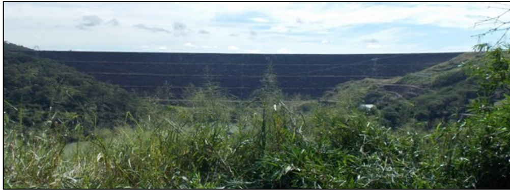
Figura 6 – Vista frontal da barragem da UHE Emborcação
