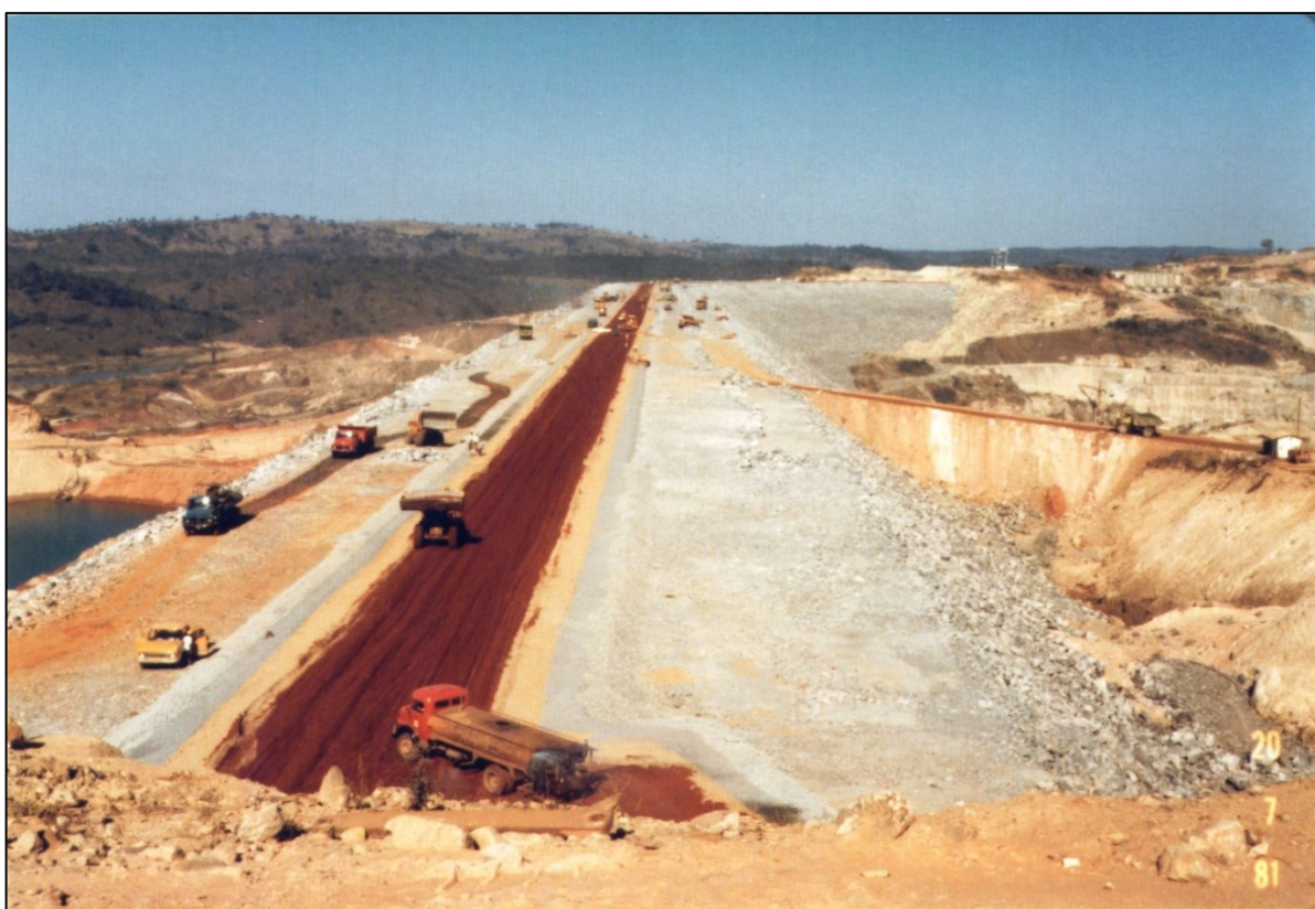
Figura 5 – Construção da UHE Emborcação
