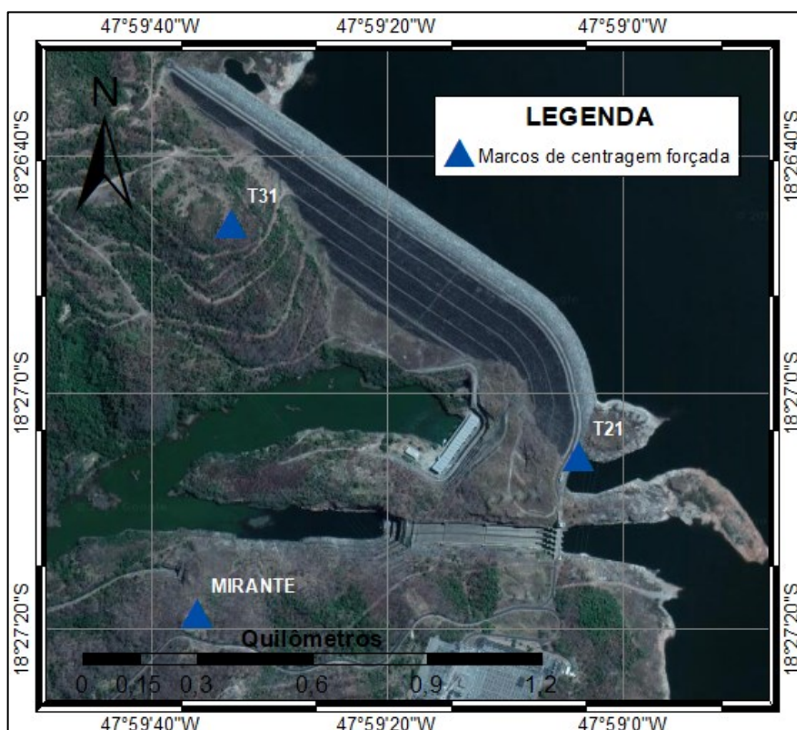
Figura 12 – Localização dos marcos de centragem forçada na UHE Emborcação
