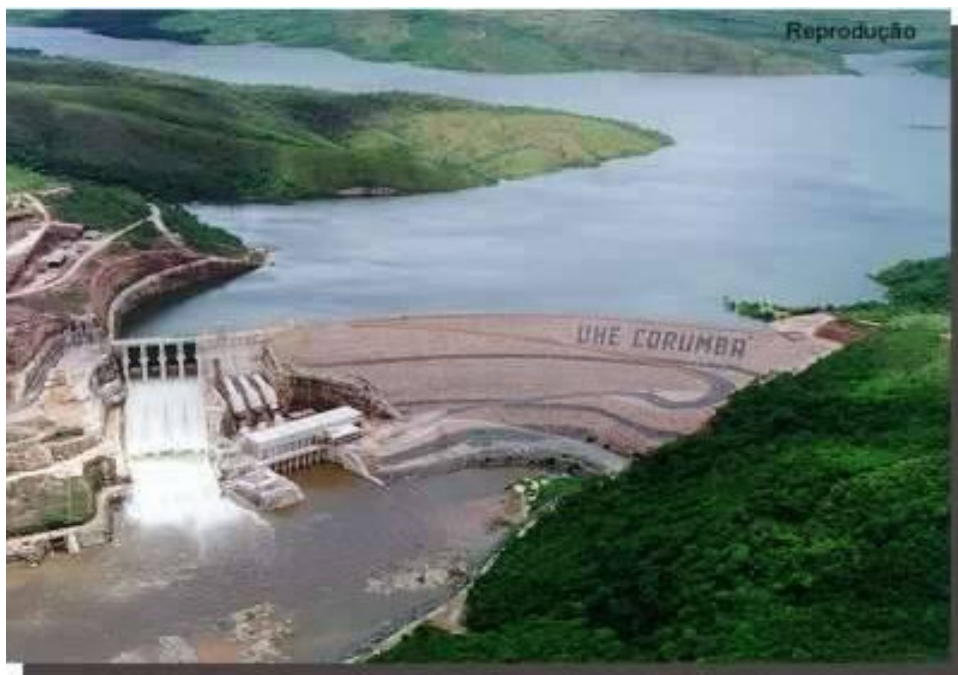
Figura 1: visão do Lago de Corumbá e da Usina Hidrelétrica de Corumbá. Fonte: Plano Diretor de Caldas Novas, 2000.
