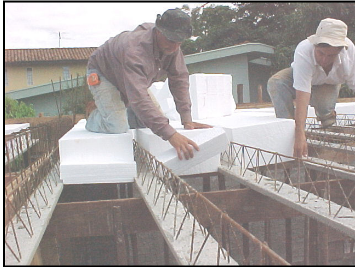
Figura 3.17 - Colocação do material de enchimento (EPS).
