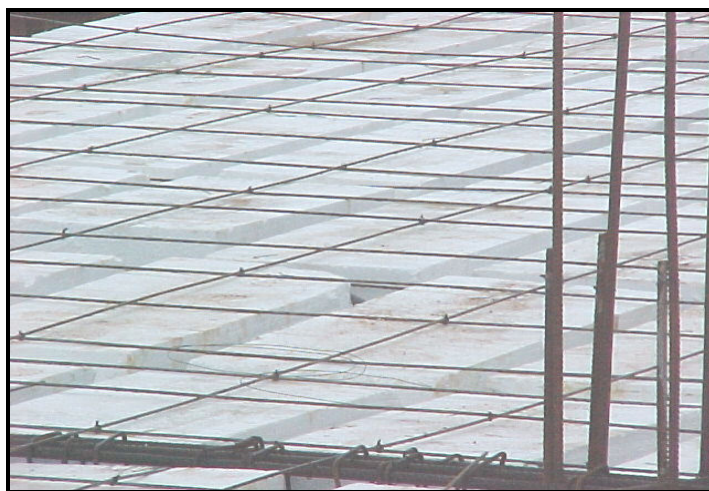
Figura 3.24 - Detalhe da colocação da tela de distribuição na capa da laje.
