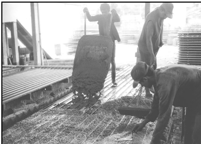
Figura 3.5 - Lançamento e nivelamento do concreto sobre as fôrmas [PUMA (2002)].
