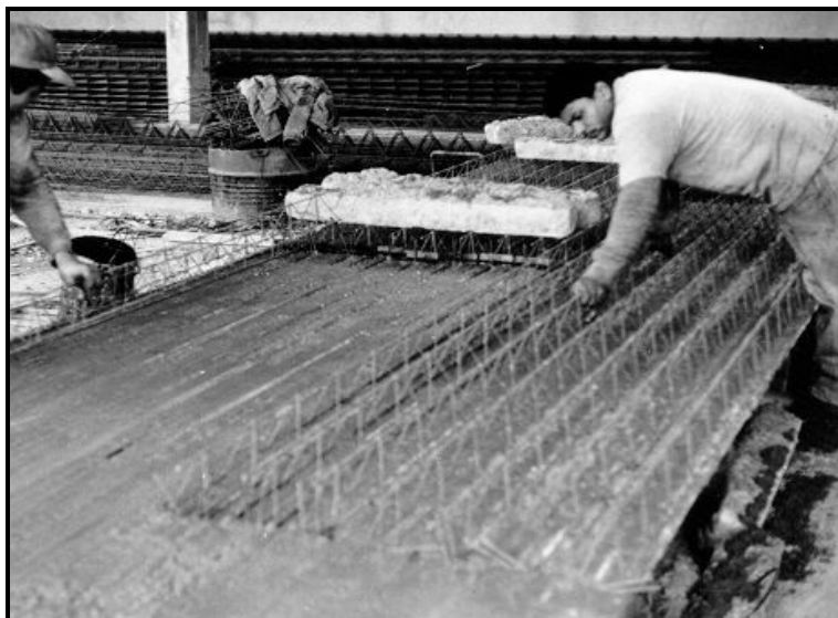
Figura 3.11 - Adequação da treliça metálica no concreto [PUMA (2002)].
