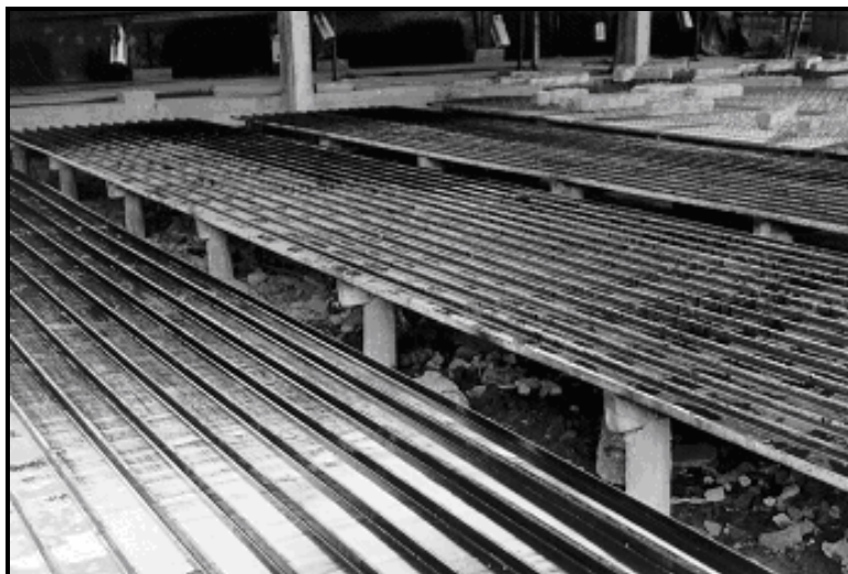
Figura 3.3 - Pátios de concretagem para a produção das vigotas [PUMA (2002)].
