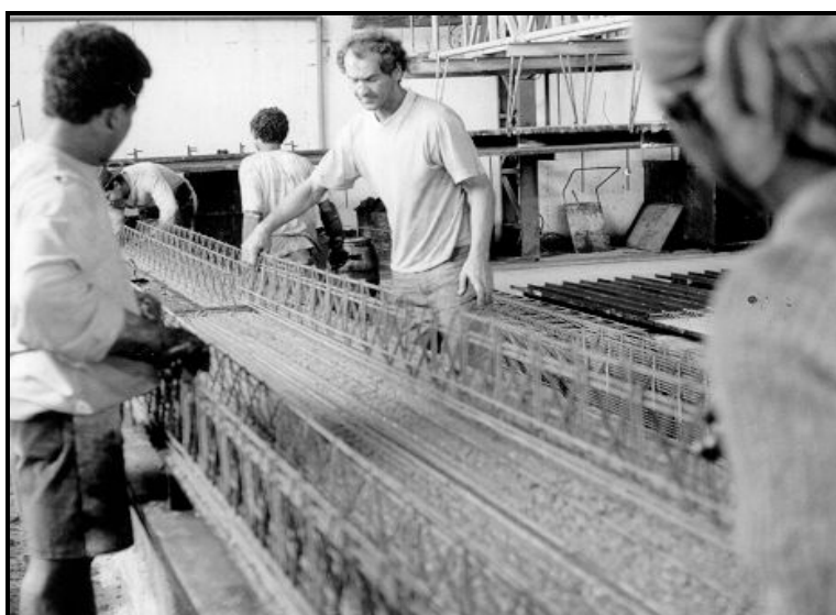
Figura 3.12 - Desforma das vigotas já concretadas [PUMA (2002)].
