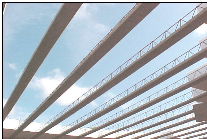
Figura 3.15 - Forma de apoio das vigotas treliçadas.
