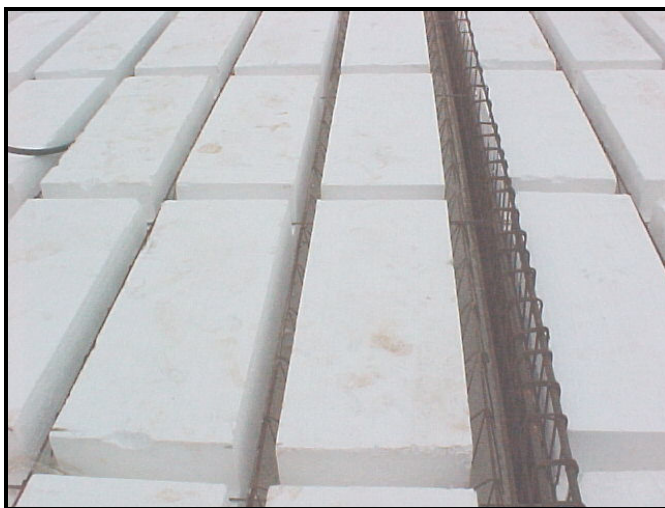
Figura 3.20 - Colocação das armaduras adicionais.
