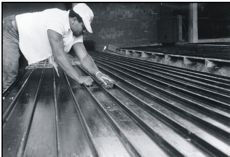
Figura 3.4 - Aplicação do desmoldante em fôrmas devidamente posicionadas, limpas e secas [PUMA (2002)].
