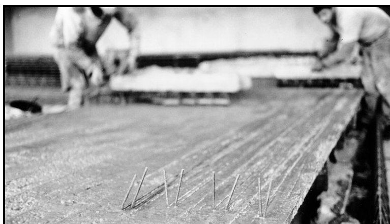
Figura 3.6 - Posicionamento da armadura adicional no concreto [PUMA (2002)].
