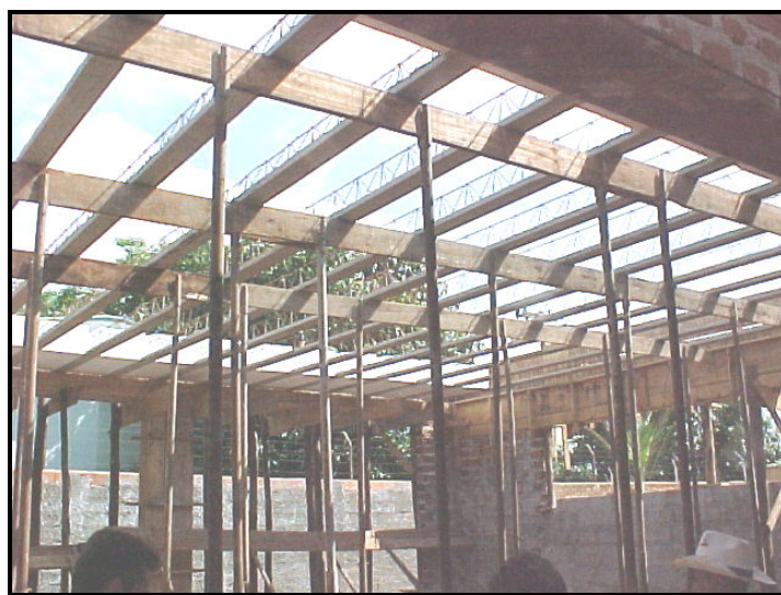
Figura 3.16 - Regulagem da altura de cada linha de escoramento.
