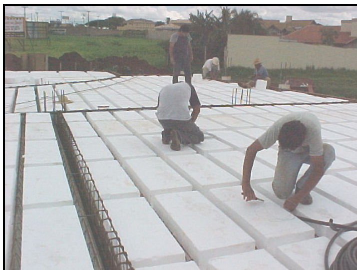
Figura 3.23 - Colocação de eletrodutos, tubulações de hidráulica e caixas de luz.
