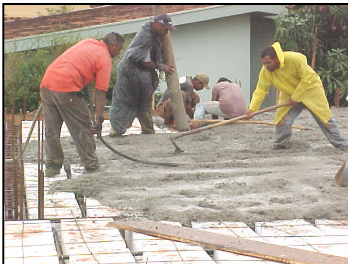
Figura 3.25 - Concretagem da laje pré-moldada.
