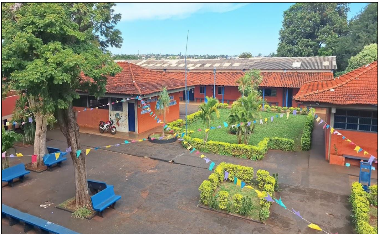
Figura 2- Vista Panorâmica do segundo piso para o pátio interno EEGIP, 2026. Fotografia da autora. Acervo pessoal.
