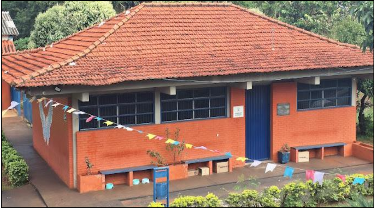
Figura 3- Detalhe pátio interno EEGIP, lado direito a partir do portão entrada, 2026. Fotografia da autora. Acervo pessoal.
