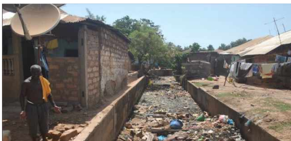
FIGURA 16: Valeta a céu aberto no bairro. Fonte: Google, Acessado em 25-10-2018, organizado pelo autor, 2018.
