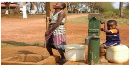
FIGURA 14: Abastecimento de água, fontenário público.
