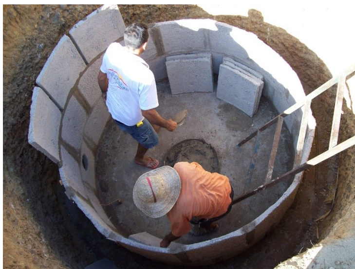
Figura 9: Biodigestor sertanejo a partir de placas pré-moldadas de cimento.
