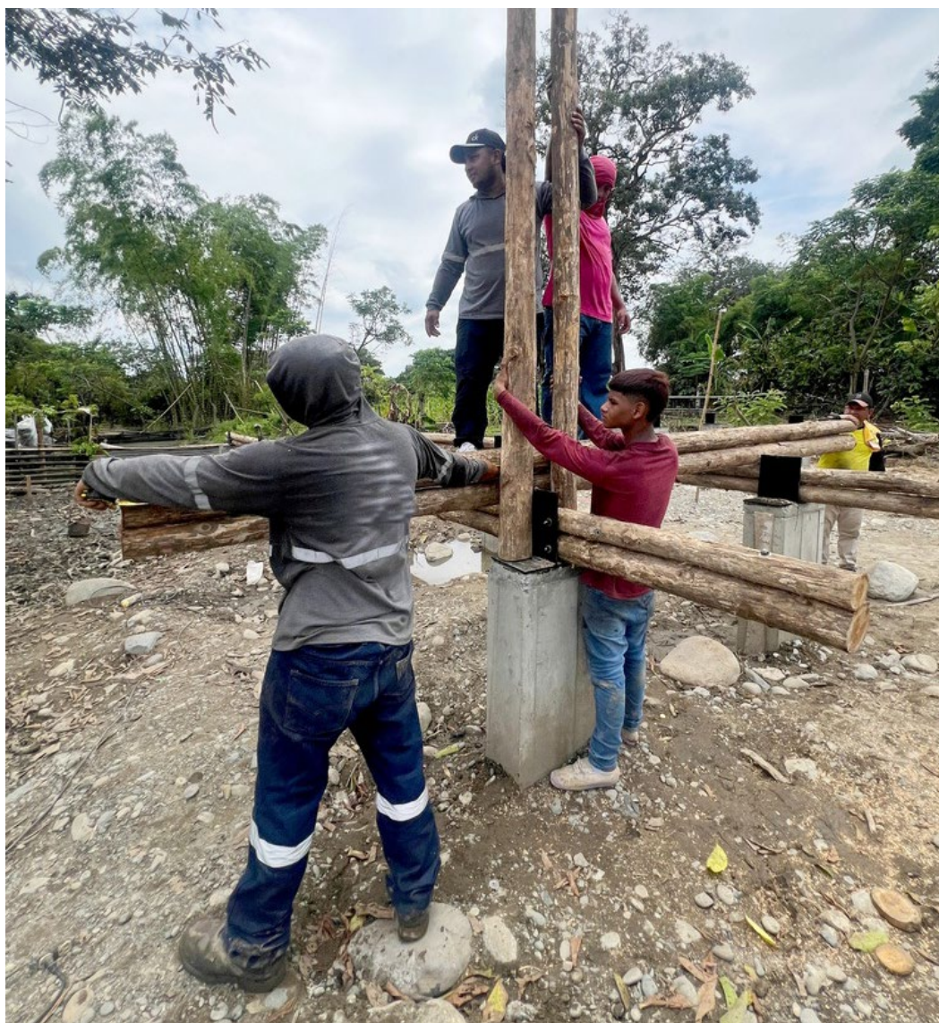
Figura 28 - Construtores locais montando a estrutura do La Panificadora
