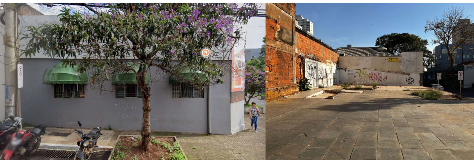
Figura 7 - Edifício demolido, rua Machado de Assis, Uberlândia; [1] 2023; [2] 2025
