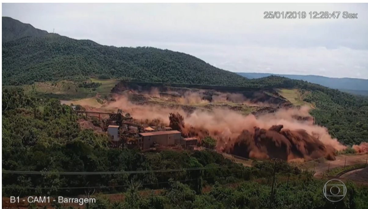
Figura 2 – Rompimento da barragem da Vale em câmera de monitoramento
