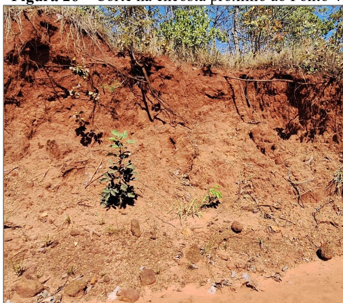
Figura 26 – Corte na encosta próximo ao Ponto 4
