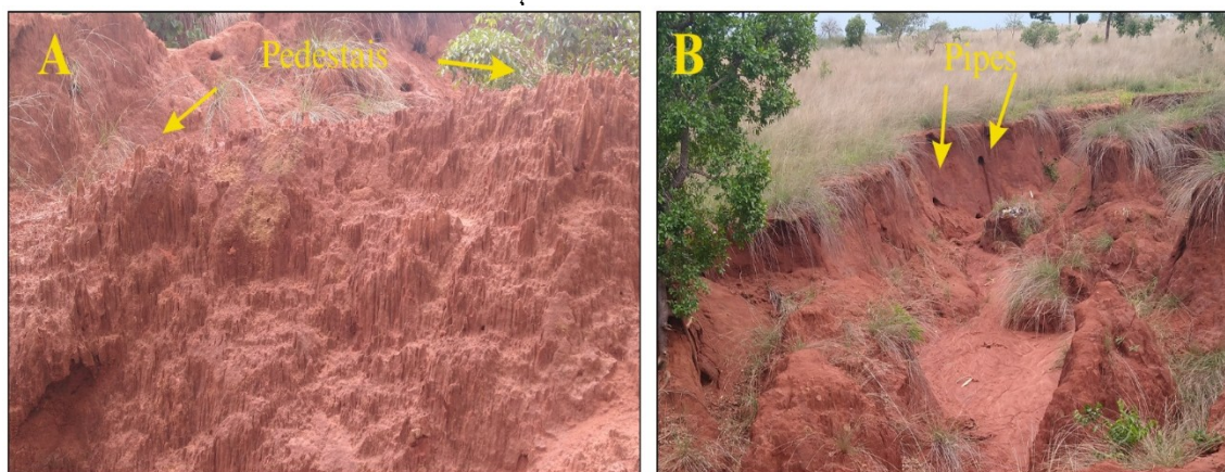
Figura 56 – (A) Registro de demoiselles (pedestais); (B) Presença de pipes na parede da voçoroca no Ponto 4
