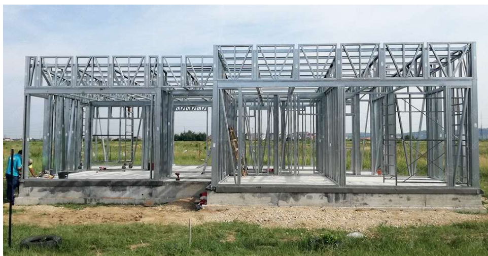
Figura 3: Estrutura metálica de edificação em LSF.
