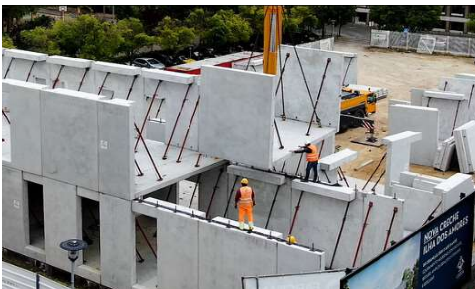
Figura 2: Esquema de paredes pré-moldadas de concreto.
