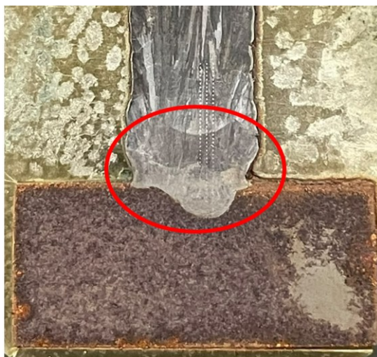
Figura 4.3 – Detalhe da interface, com indicação da corrosão após um mês de preparação.
