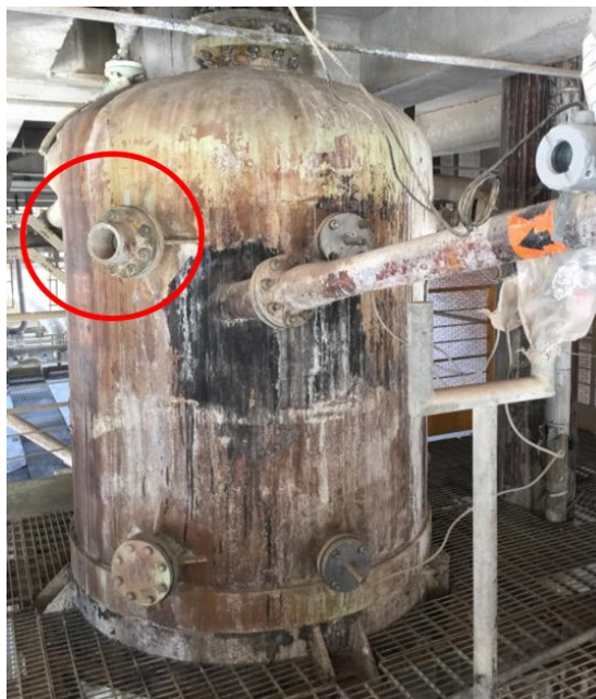
Figura 4.39: Vaso de reciclo, com demarcação do ponto de dosagem (do autor)
