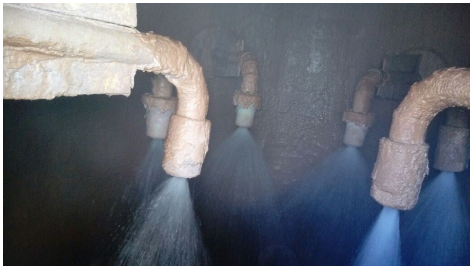
Figura 2.28: Bicos para alimentação de água em torre de absorção de \text{H}_2\text{SiF}_6 (do autor)
