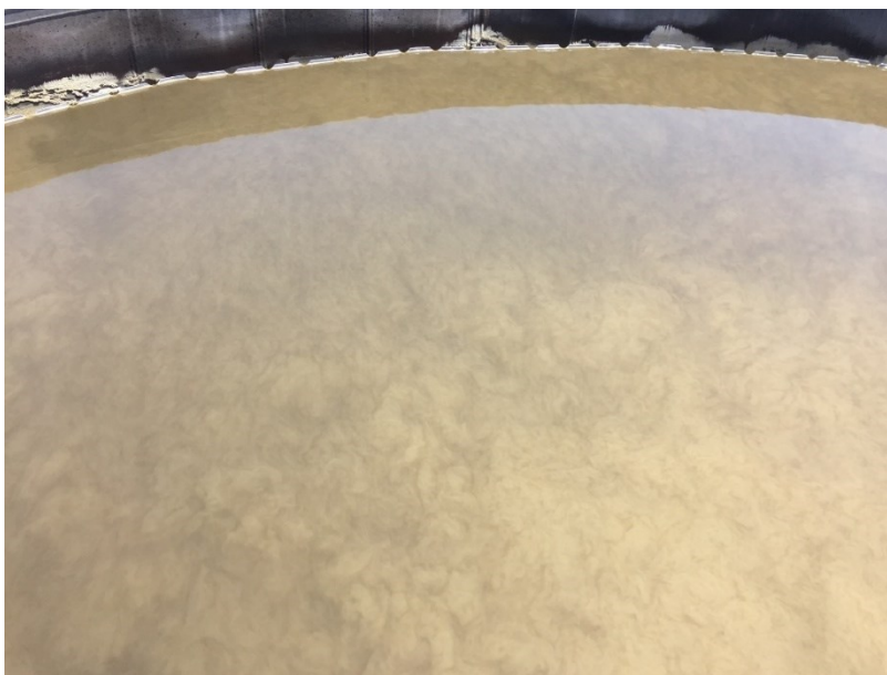
Figura 2.24: Decantador industrial em operação (do autor)
