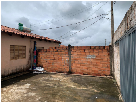
Figura 4.10(d) - Pavimentação total do lote
