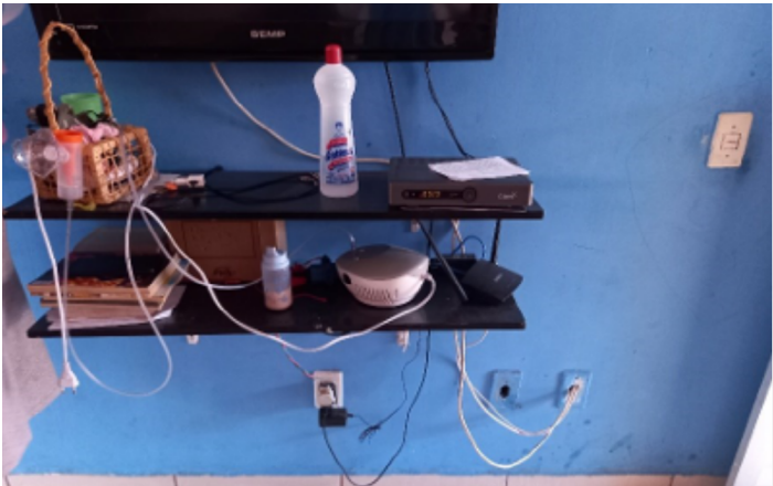
Figura 4.3 - Tomadas sobrecarregadas.
