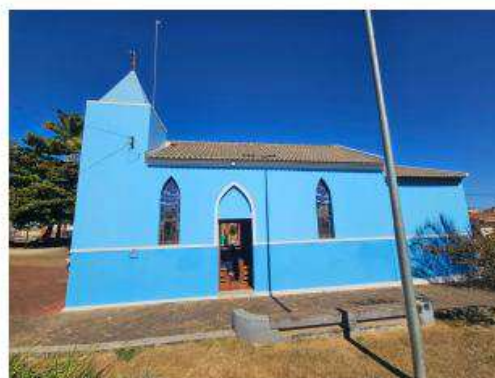
Capela de Nossa Senhora do Rosário: Alvenarias sem danos. Foto: Tony Rodrigues, 06/11/2024
