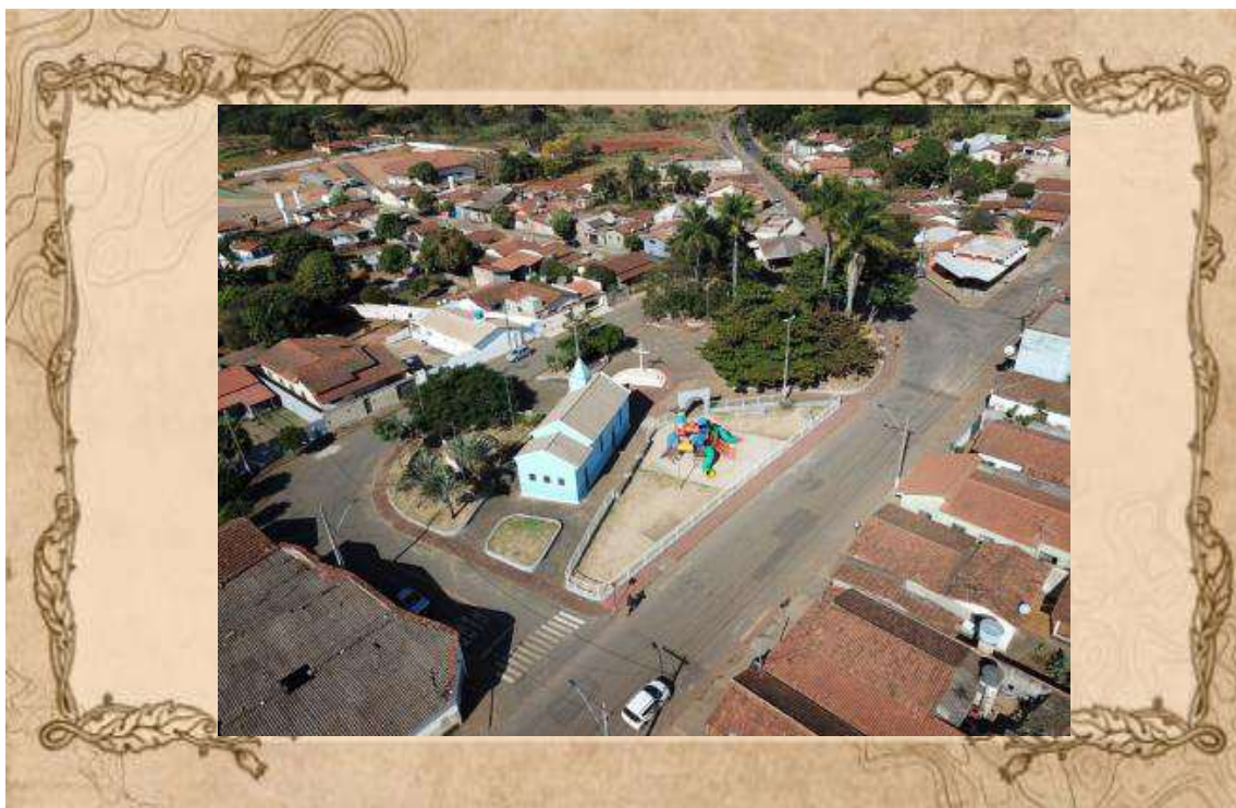
Laudo Técnico: Capela de Nossa Senhora do Rosário: Entorno. Foto: Tony Rodrigues, 06/11/2024
