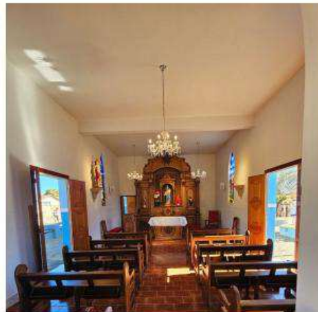
Capela de Nossa Senhora do Rosário: laje com bom estado geral de conservação. Foto: Tony Rodrigues, 06/11/2024
