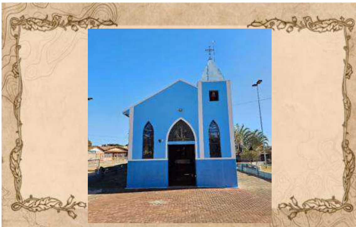
Laudo Técnico: Vista da fachada frontal da Capela de Nossa Senhora do Rosário. Foto: Tony Rodrigues, 06/11/2024
