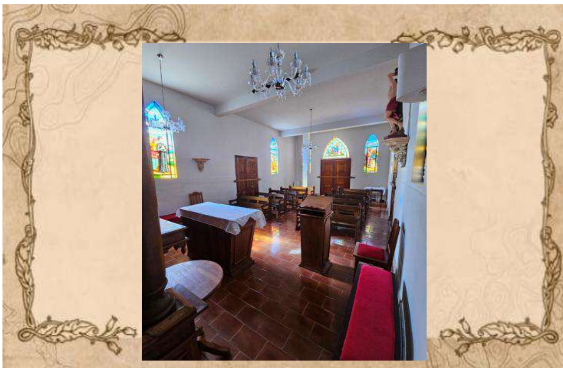
Laudo Técnico: Capela de Nossa Senhora do Rosário, sem danos estruturais. Foto: Tony Rodrigues, 06/11/2024
