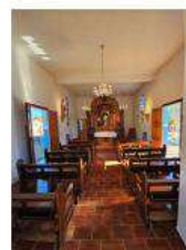
Capela de Nossa Senhora do Rosário: estrutura sem danos. Foto: Tony Rodrigues, 06/11/2024
