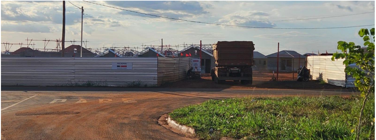
Imagem 4 - Loteamento em Construção, Ituiutaba (MG)
