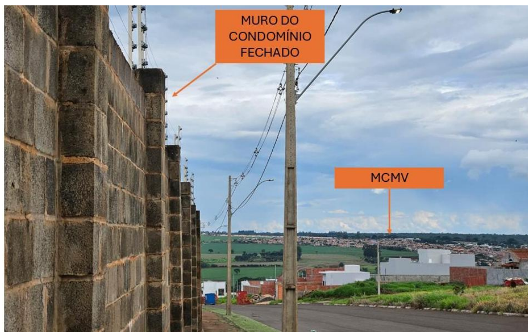
Imagem 6: Visão Panorâmica das Estruturas Urbanas, Jataí (GO)
