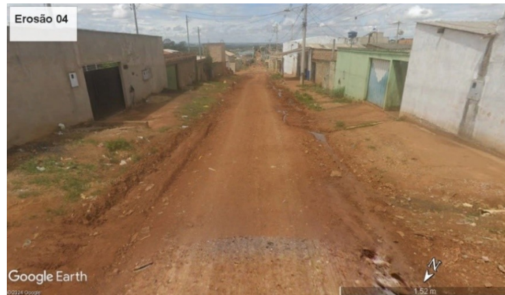
Figura 11. Erosão localizada na rua Frei Tito
