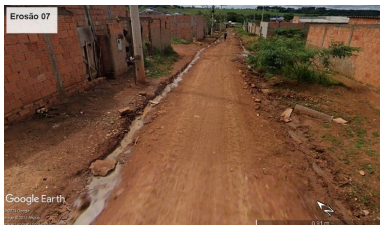
Figura 14. Erosão localizada no quinto quarteirão da rua Paulo Alexandre Garcia
