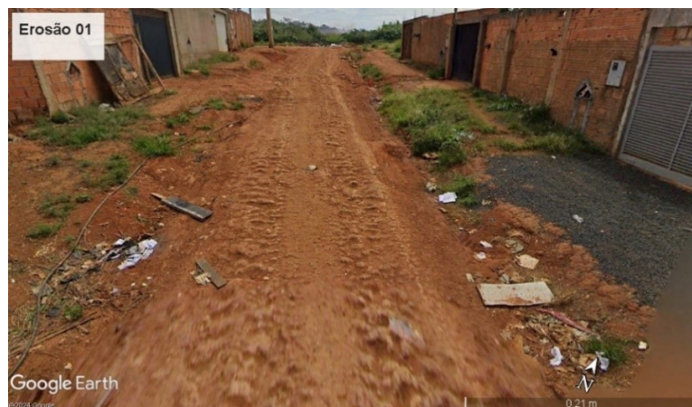
Figura 8. Erosão localizada na rua Luiz Humberto Lucena
