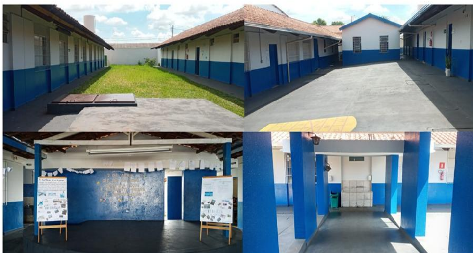
Figura 02 – Aspectos do exterior da escola e percepção parcial de sua infraestrutura.
