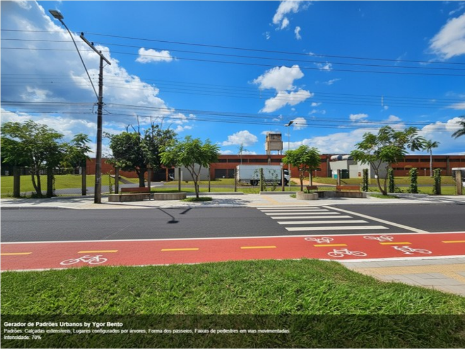
Figura 169 - Trecho 02 Vista 01 Foto 02
