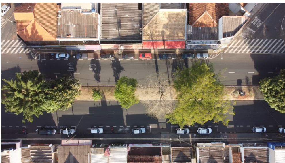
Figura 108 – Trecho 2 da avenida
