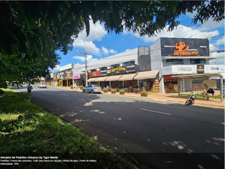
Figura 188 - Trecho 05 Vista 01 Foto 03
