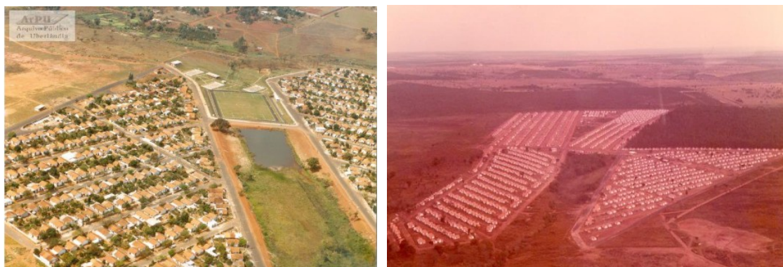
Figura 28 e 29 – Conjunto Luizote de Freitas
