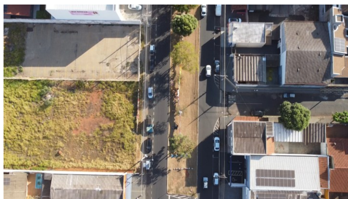
Figura 104 – Trecho 1 da avenida
