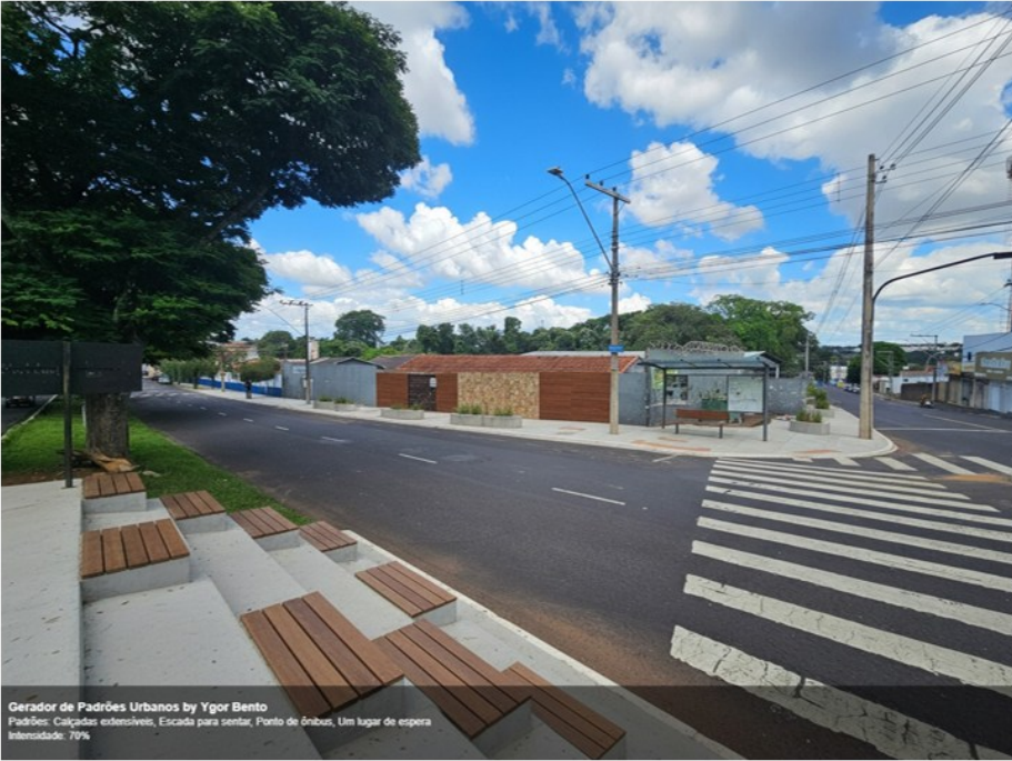
Figura 199 - Trecho 05 Vista 03 Foto 02
