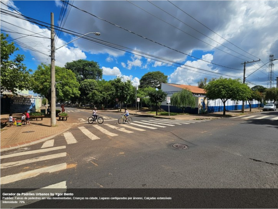
Figura 192 - Trecho 05 Vista 02 Foto 02
