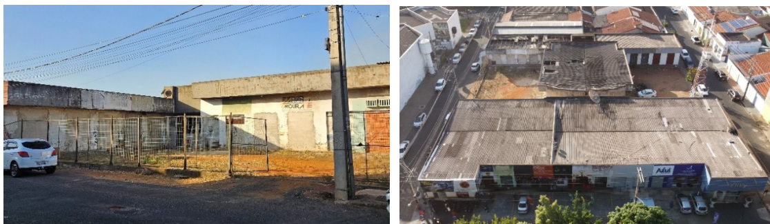
Figura 85 e 86 – Local abandonado
