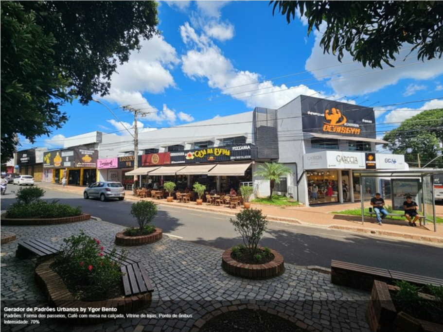
Figura 187 - Trecho 05 Vista 01 Foto 02
