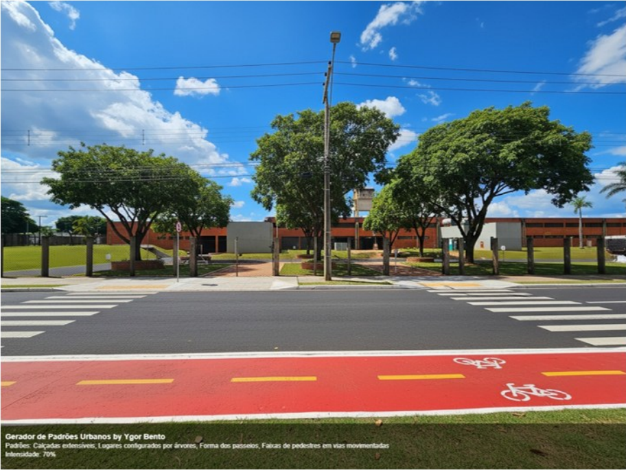
Figura 170 - Trecho 02 Vista 01 Foto 03
