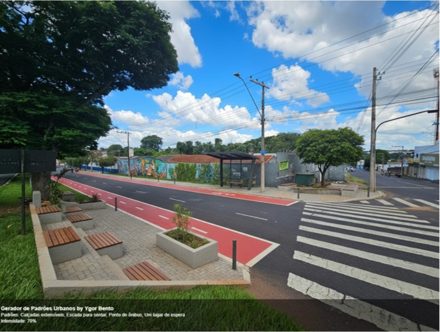
Figura 200 - Trecho 05 Vista 03 Foto 03
