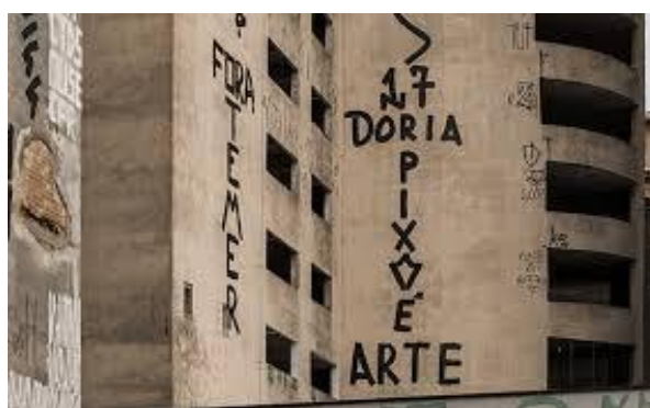
Figura 7: Pichação sob prédio “Dória, pixo é arte”. Fonte: Revista Fórum, 2017.
