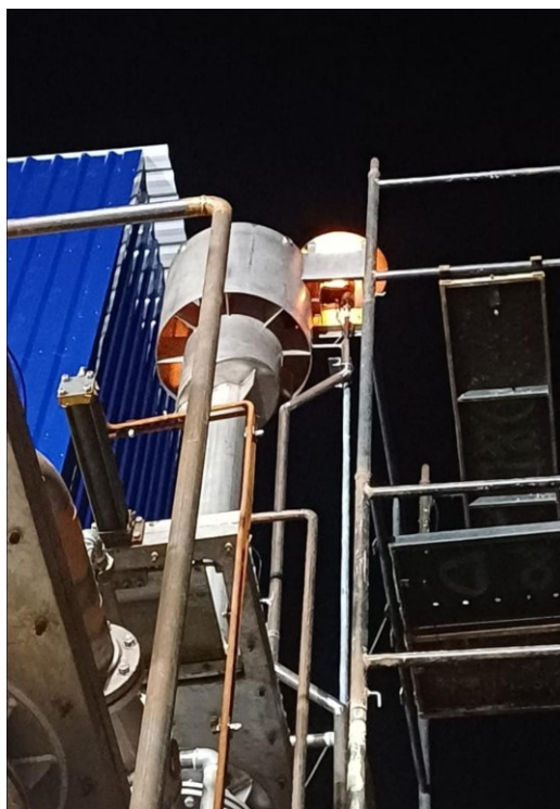
Figura 4.18 – Teste de acionamento do flare.
