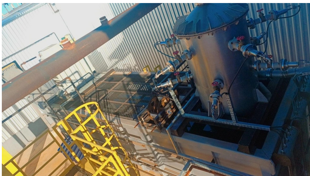
Figura 3.5 – Vista superior do Tanque de Decantação.
