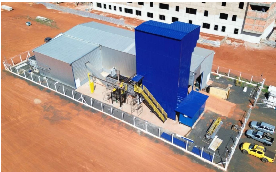
Figura 4.2 – Fechamento do prédio de gaseificação em 2026.
