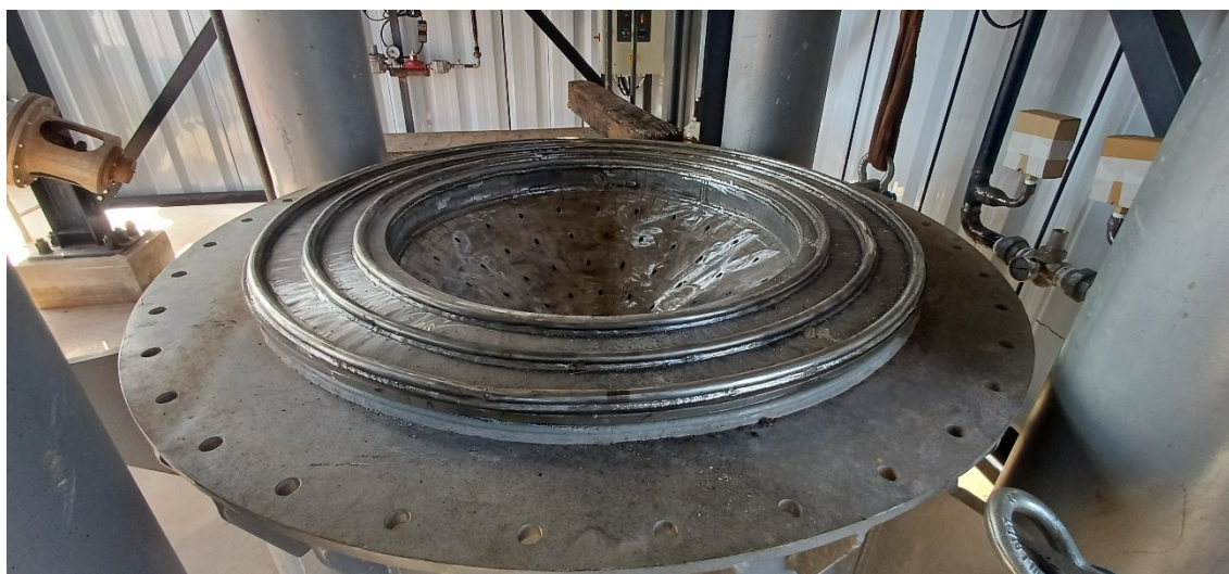
Figura 2.5 – Montagem da grelha no plenum.
