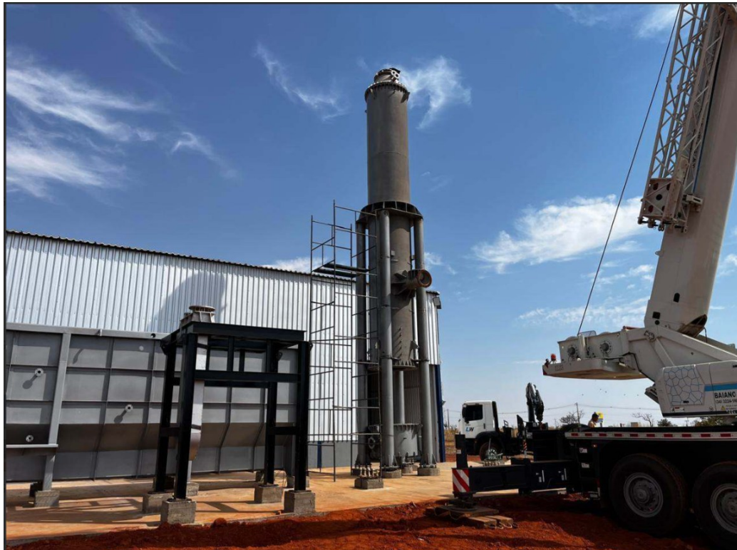
Figura 2.3 – Instalação do reator em 2025.
