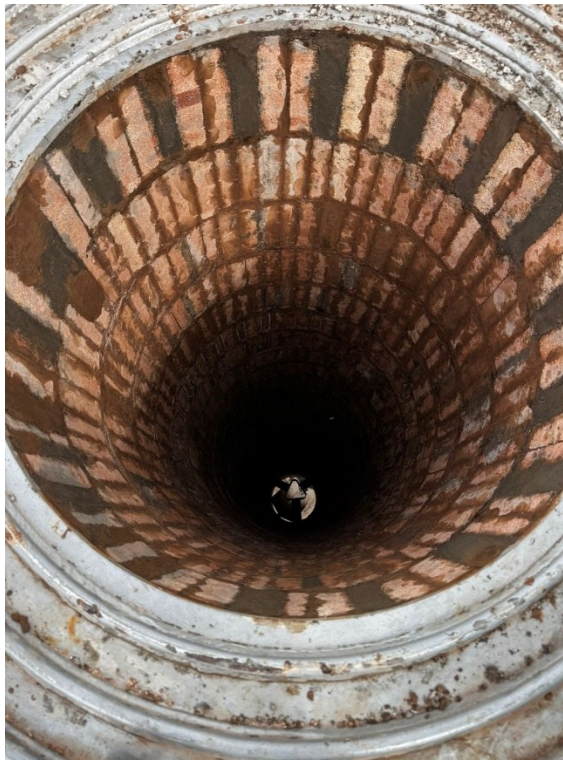
Figura 2.4 – Montagem do refratário no reator em 2026.
