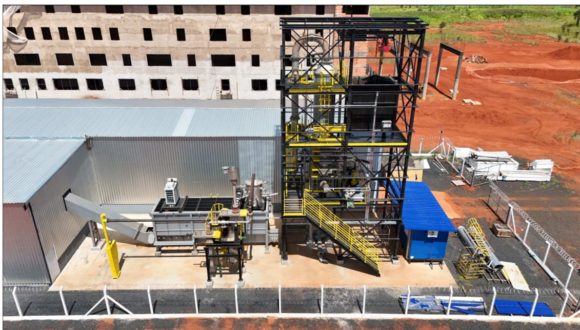
Figura 4.1 – Conclusão da estrutura do prédio de gaseificação.
