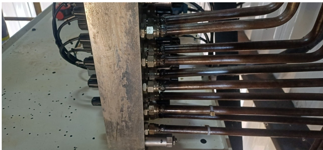
Figura 4.9 – Verificação da estanqueidade da tubulação.
