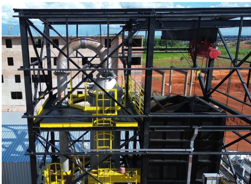
Figura 2.6 – Instalação dos trocadores de calor curvo e reto.
