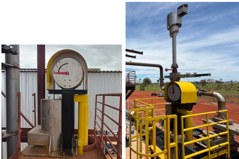
Figura 3.7 – a) Válvula Reguladora de Pressão e b) Válvula Reguladora de Vazão.
