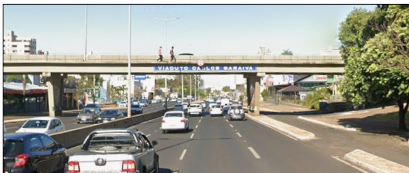
Figura 6 – Viaduto Carlos Saraiva sentido zona oeste
