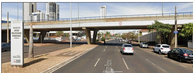
Figura 7 – Viaduto José Rezende Ribeiro sentido zona oeste
