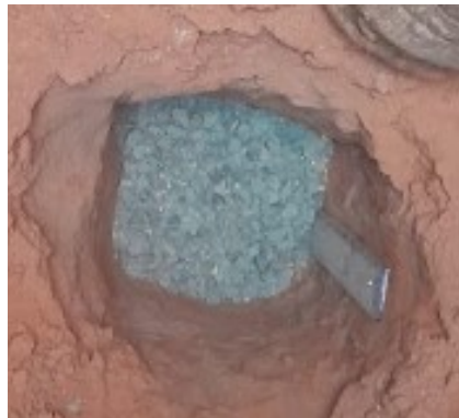
Figura 18 - Vala menor com 5 centímetros de brita
