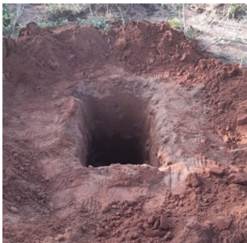
Figura 15 - Vala de 1,5 metros de profundidade
