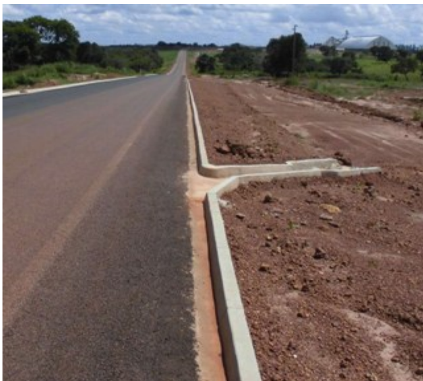
Figura 8 - Sarjetas de Aterro
