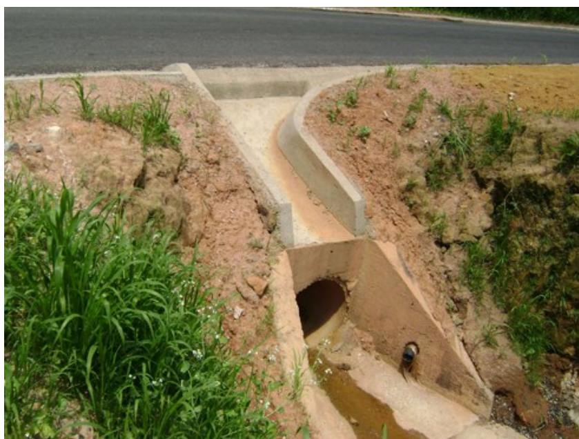
Figura 14 - Descida d'Água lisa
