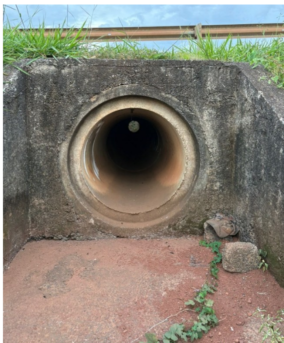
Figura 32 – Bueiro tubular de concreto do km 43 + 000
