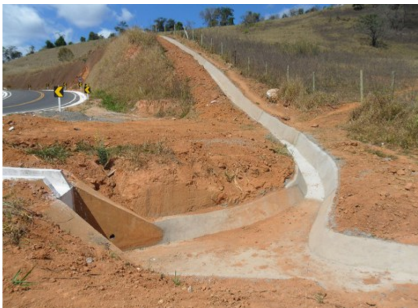
Figura 4 - Valetas de Proteção de Corte
