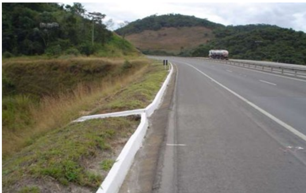
Figura 12 – Entrada para Saída d' Água de Aterro
