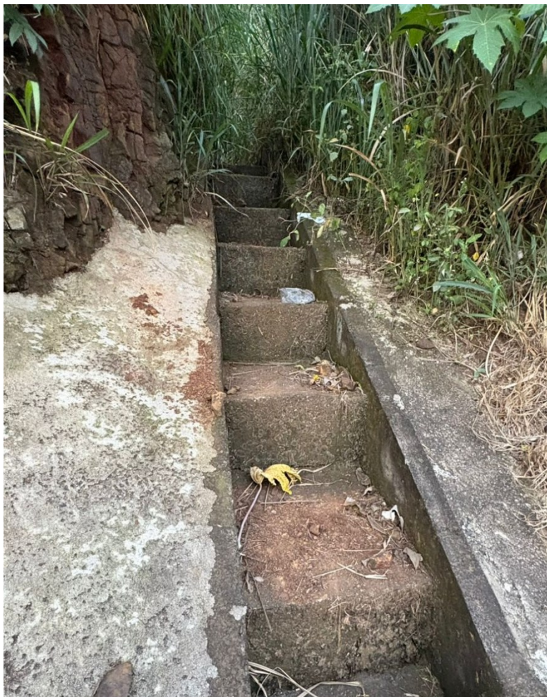
Figura 34 – Descida d'água em degraus no km 48 + 100
