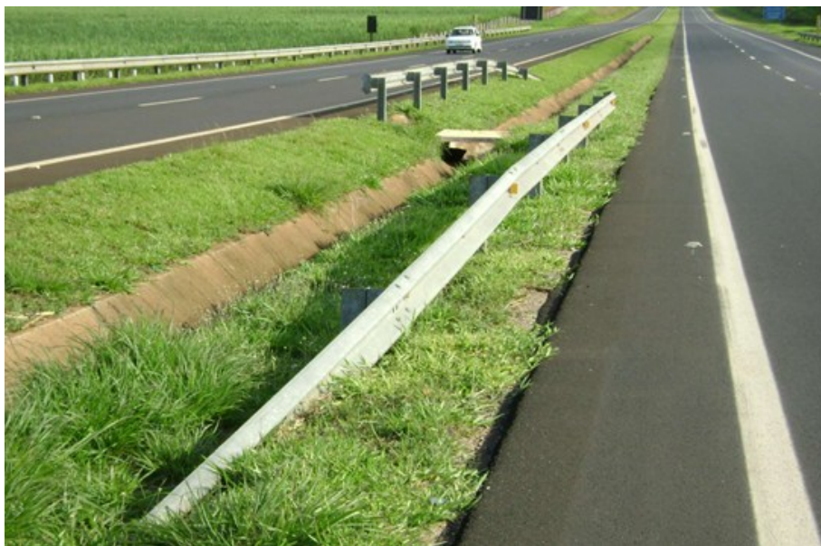
Figura 10 - Sarjetas de Canteiro Central
