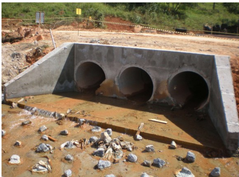
Figura 17 - Dissipadores de Energia
