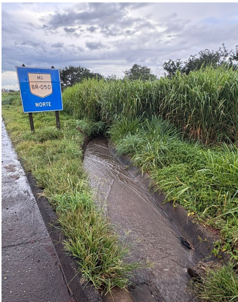
Figura 33 – Descida d'água lisa no km 65 + 200
