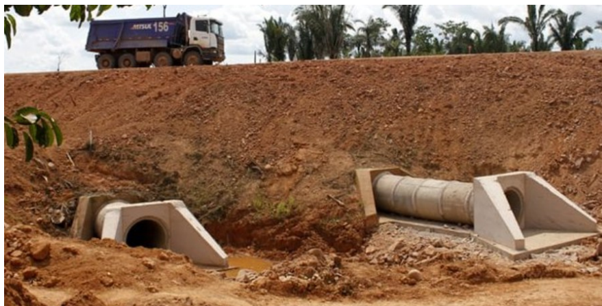
Figura 18 - Bueiro Simples Tubular de Concreto
