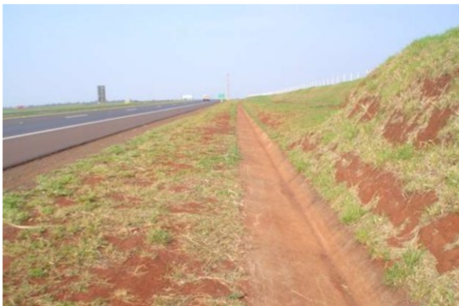
Figura 6 - Sarjetas de Corte
