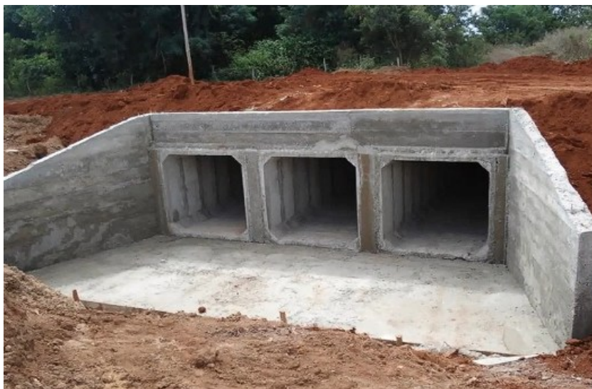
Figura 19 - Bueiro Triplo Celular de Concreto
