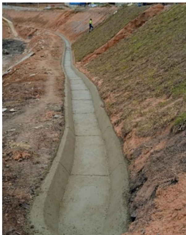
Figura 5 - Valetas de Proteção de Aterro
