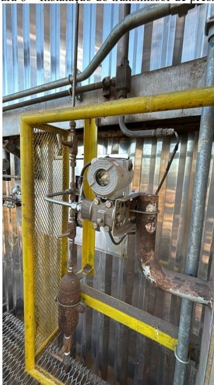
Figura 6 – Instalação do transmissor de pressão
