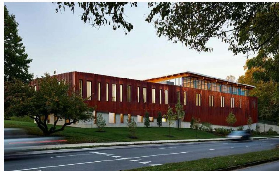
Figura 87: Fachada do Lubber Run. Fonte: VMDO, [s.d.].
