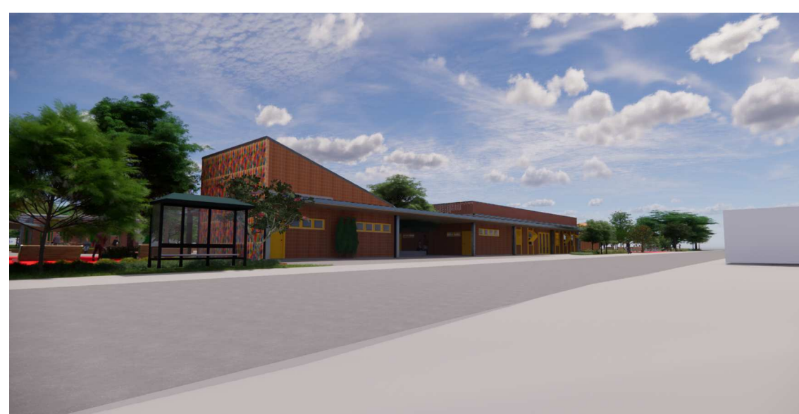
PERSPECTIVA A PARTIR DA ESQUINA E RUA CRISANTINO, COM BANHEIROS COM PAREDE DE INTERVENÇÃO E SETOR DE ALIMENTAÇÃO
