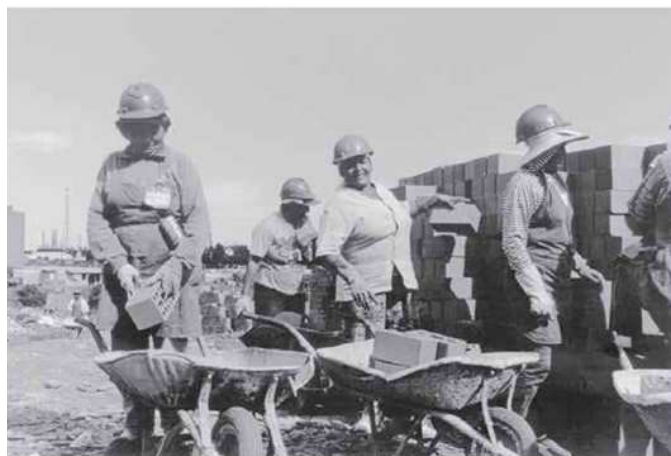
Figura 7 – Mulheres trabalhando na construção de moradias em mutirão autogerido.
