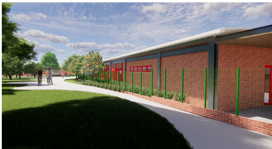
Figura 129 – Tijolinhos (tijolo maciço), esquadrias coloridas, bambu e cobogós.
