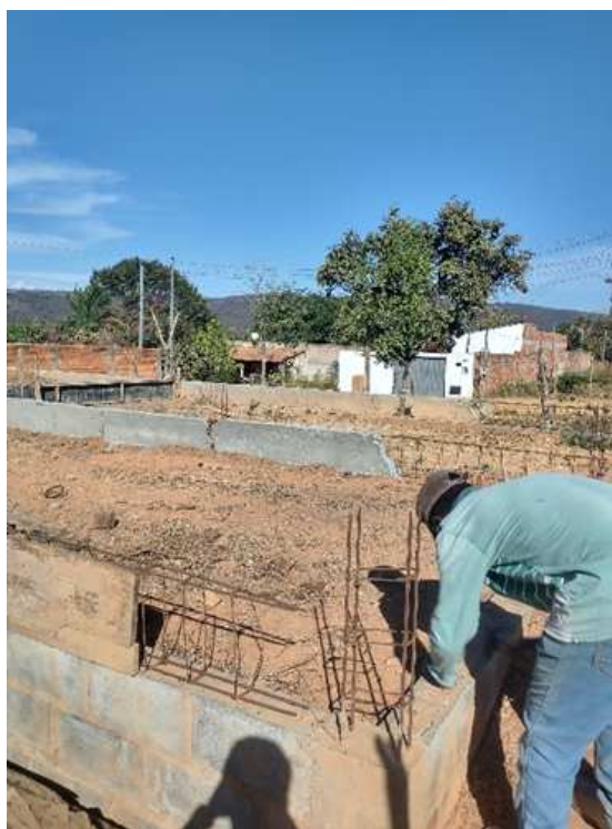
Figura 28 – Morador executando a obra de sua futura residência.
