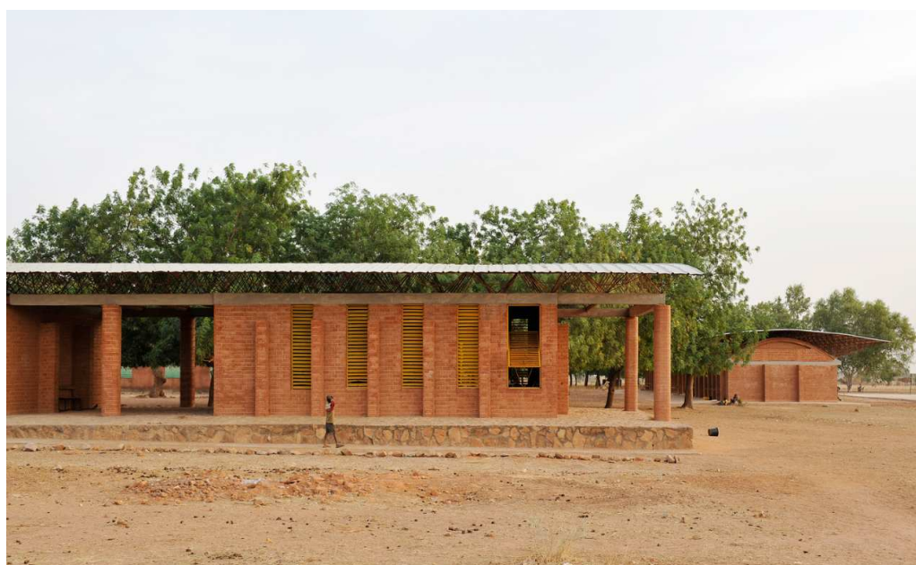
Figura 55 – Fachada evidenciando o ritmo, janelas coloridas e as pedras na base.
