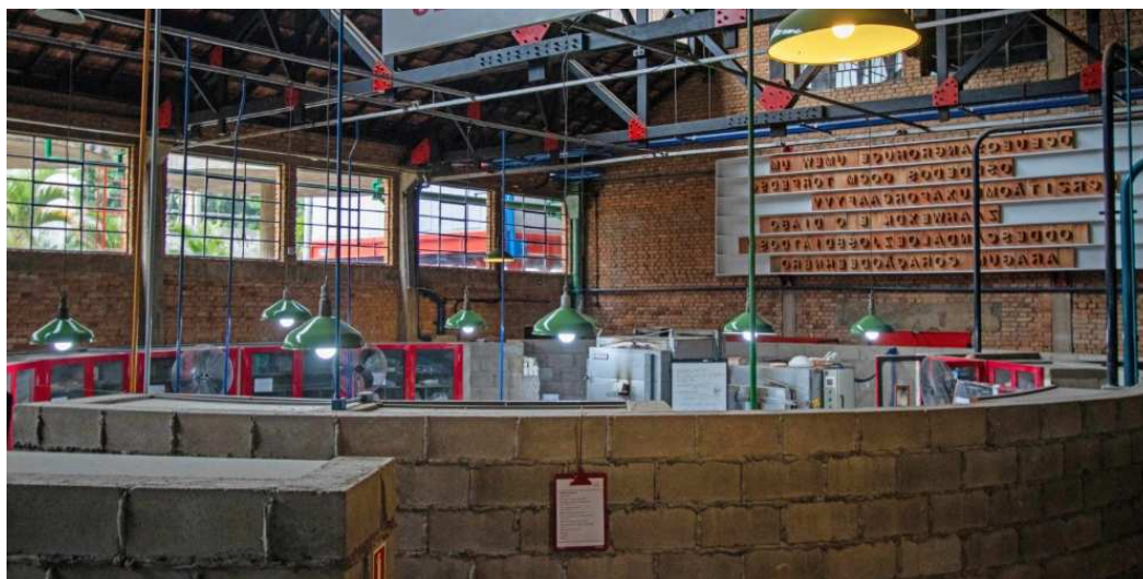
Figura 69 – Paredes de blocos de concreto delimitando a oficina.
