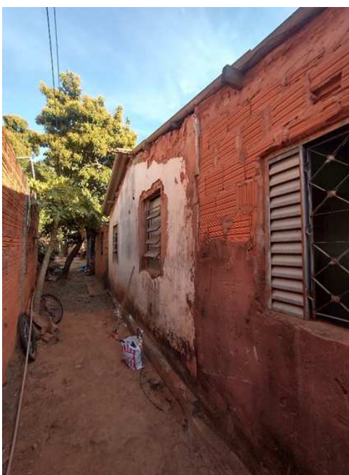
Figura 30 – Moradia expandida ao longo do tempo, sendo a porção branca correspondente à edificação original e as outras construídas posteriormente.
