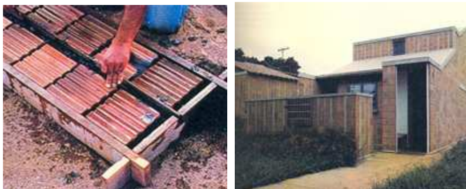
Figura 62 – Processo construtivo à esquerda e residência finalizada à direita.
