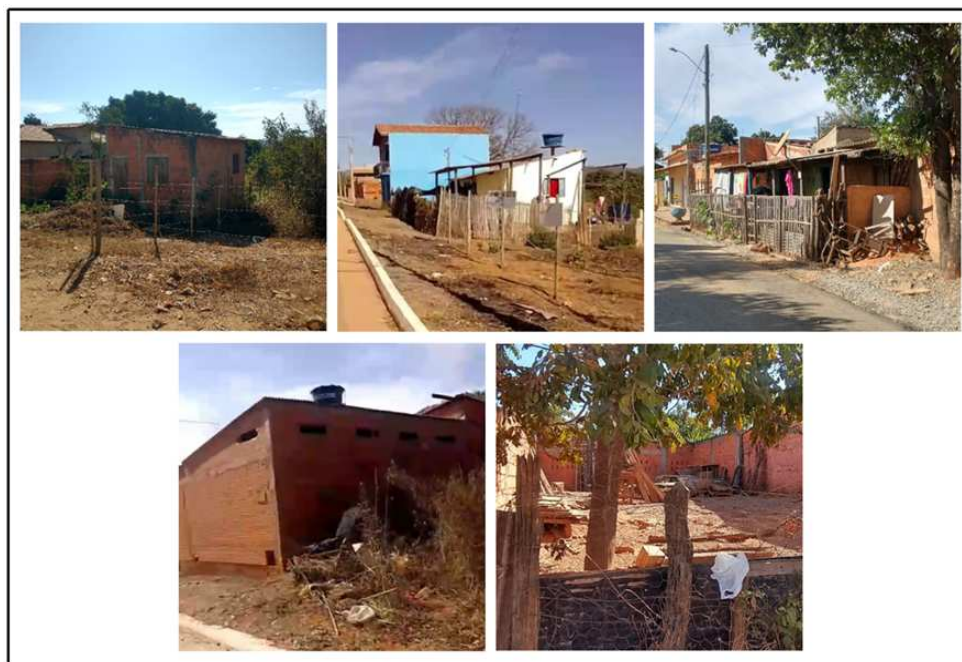
Figura 34 – Residências no bairro São Geraldo II.
