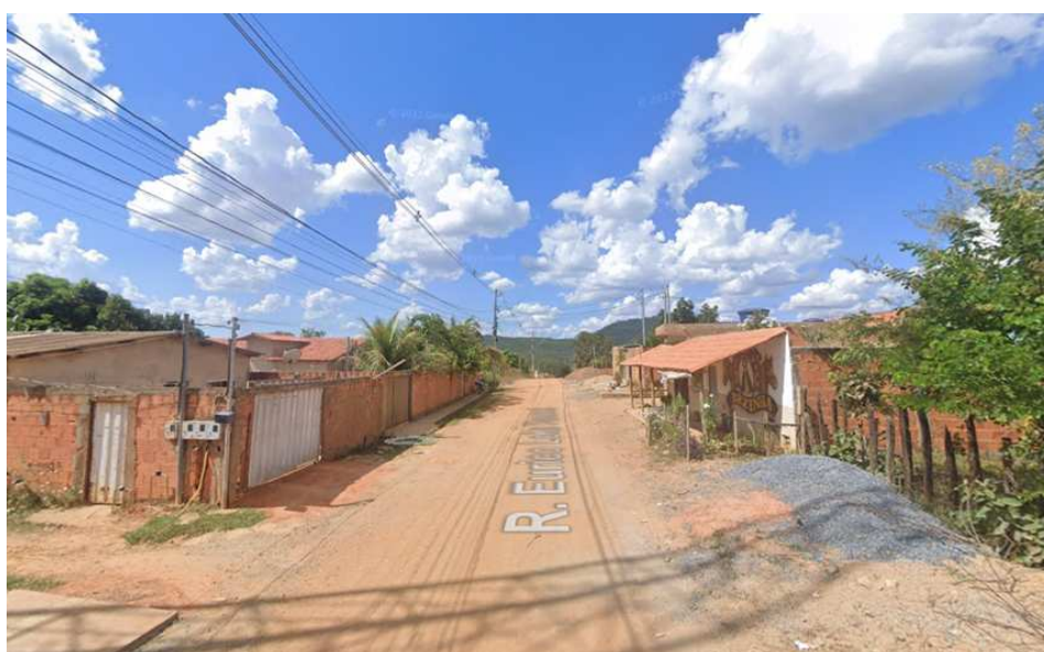
Figura 18 – Rua sem pavimentação asfáltica.
