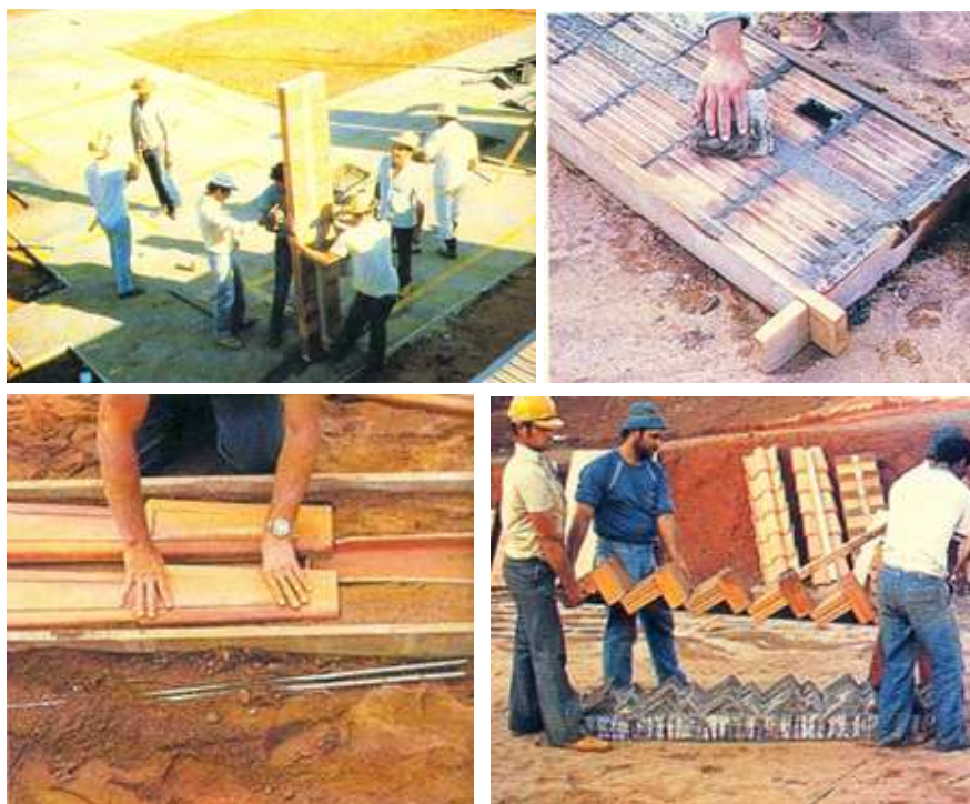
Figura 63 – Processo construtivo da pré-fabricação de paredes, cobertura e escada.
