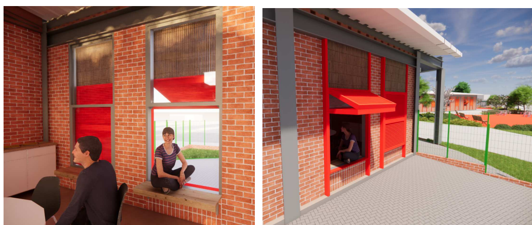
Figura 130 – Sistema combinando janela guilhotina, venezianas e bambu.
