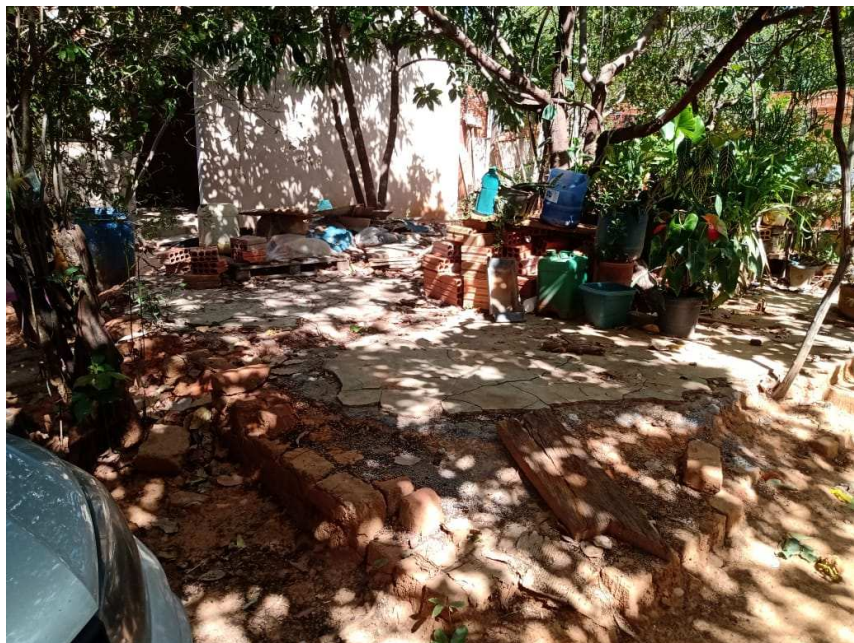
Figura 27 – Vestígios de antiga construção em adobe demolida.
