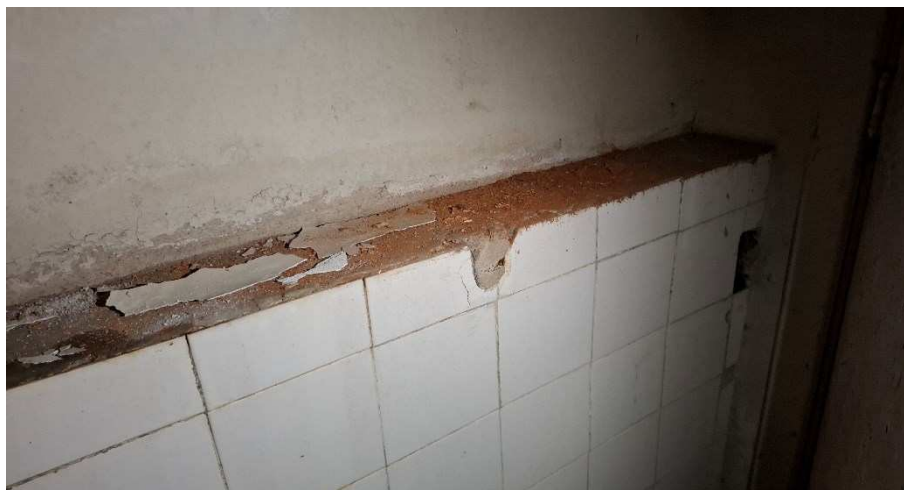
Imagem 4 – “Igrejinha”, local de apoio do pau de arara e caixa de fios para choque elétrico (autoral), 2026
